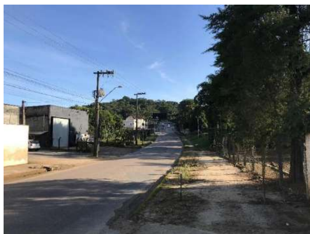
Foto 4: Trecho 7 Canal fechada em via publica, sem vegetação
