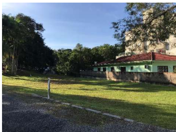
Foto 5: Trecho 08 Canal fechado em lote, sem vegetação
