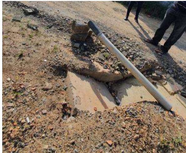
Foto 12: Trecho 10 Canal fechado em via pública
