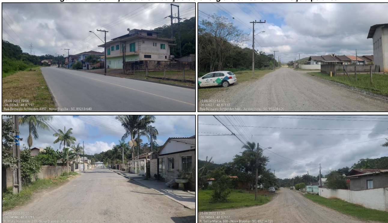
Figura 18 – Serviço de distribuição de energia elétrica e iluminação pública.
