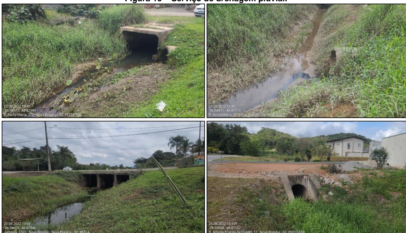
Figura 19 – Serviço de drenagem pluvial.
