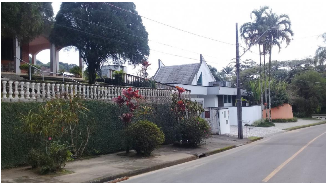
Figura 16: Redes de distribuição de energia elétrica. Fonte: Autores.
