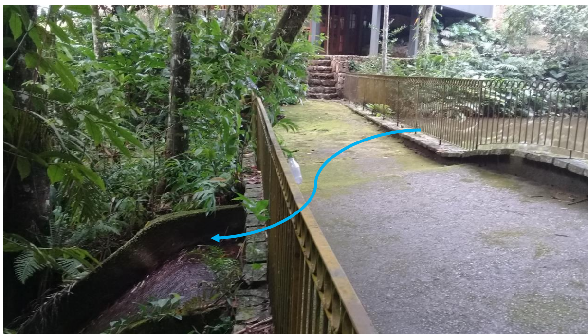
Figura 28: Trecho 4 (reservatório) para trecho 5. Fonte: Autores.
