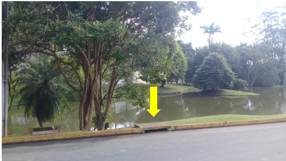
Figura 13: Boca de lobo na rua de Marseille. Fonte: Autores.
