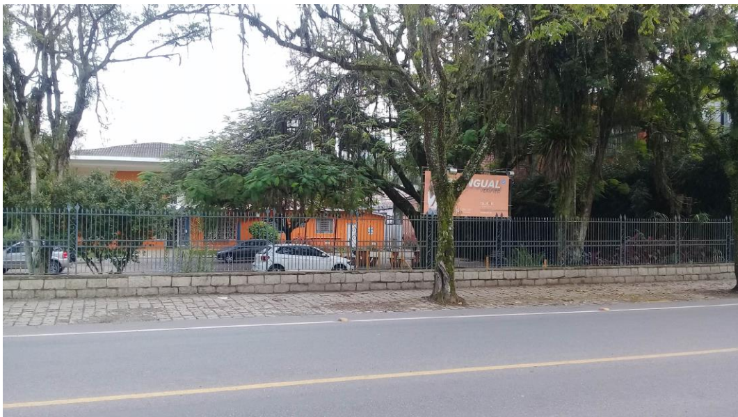
Figura 11: Cenário tubulado sob via pública (rua Dona Francisca), com árvores isoladas e edificações. Fonte: Autores.
