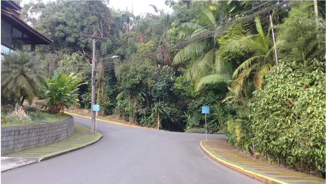
Figura 17: Redes de distribuição de energia elétrica. Fonte: Autores.
