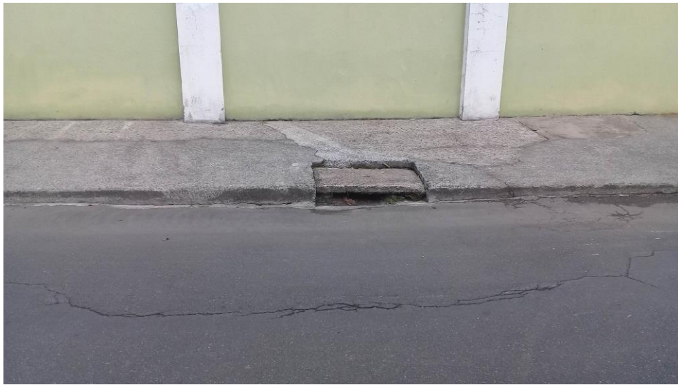
Figura 14: Boca de lobo na rua Alfândega. Fonte: Autores.
