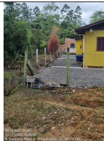
Figura 44: Edificações dentro da área de APP do trecho 24.
