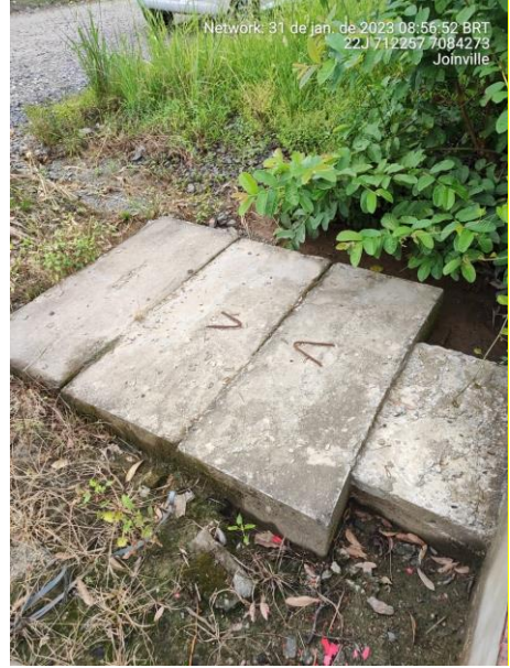
Figura 33: Início trecho 10 (tubulado), limite com trecho 6 (aberto) Fonte: Autor, 2023
