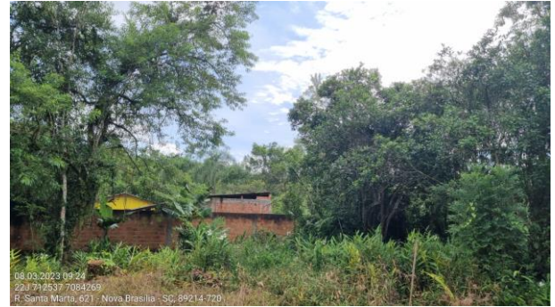
Figura 46: Edificação próxima ao trecho 23. Fonte: Autor, 2023
