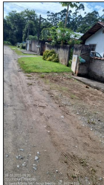
Figura 39: Região sobre o trecho 15 (tubulado). Fonte: Autor, 2023.
