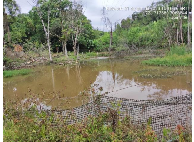
Figura 52: Trecho 83 (Reservatório Represamento) Fonte: Autor, 2023
