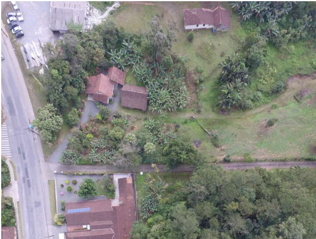
Figura 25: Vista aérea do Trecho 10 e 11.
