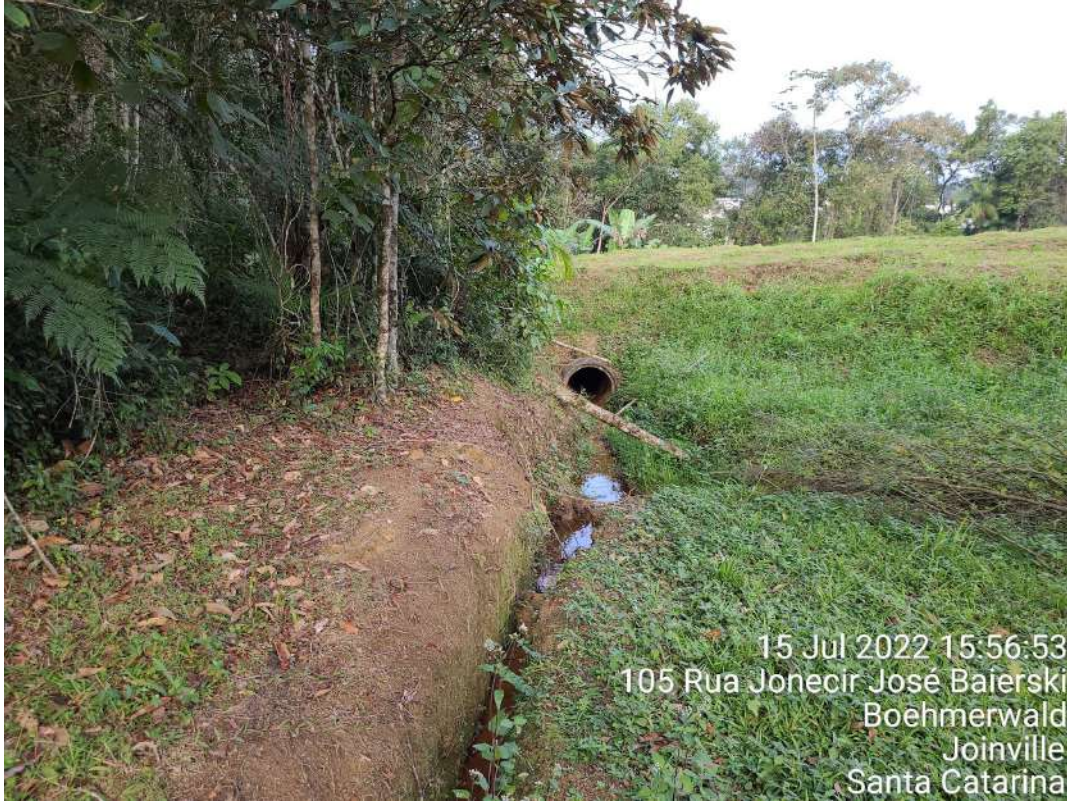
Figura 17: Início do Trecho 4, sentido sul.
