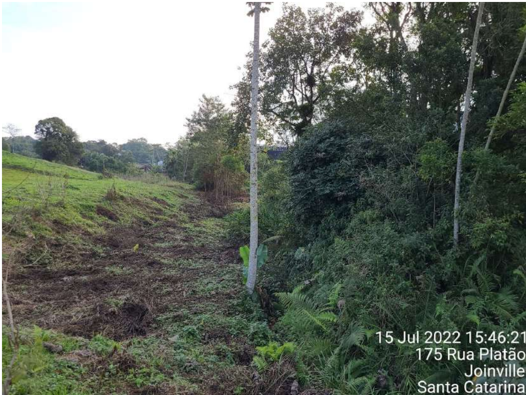
Figura 22: Aspecto geral do Trecho 9A, sentido oeste.
