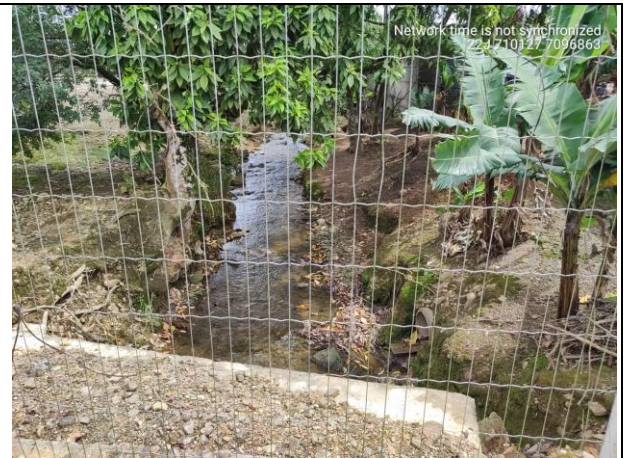
Figura 23: Trecho 47, entrada para a tubulação do trecho 48.
