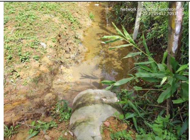
Figura 16: Início do trecho 51 tubulado, sem observação in loco da nascente. Fonte: Autor, 2022
