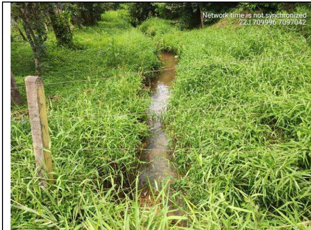
Figura 22: Trecho 45, saída da tubulação do trecho 44.
