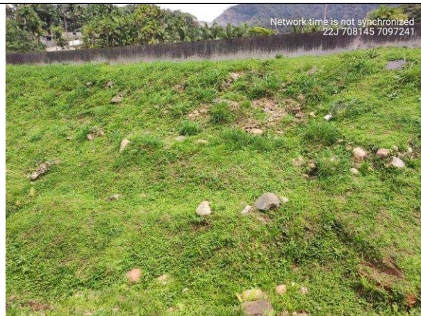
Figura 11: Trecho 12 tubulado sob via. Fonte: Autor, 2022
