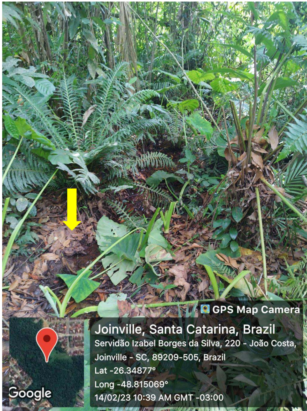
Figura 16 – Trecho 1A (Coordenadas: 718045.33 m E; 7083845.33 m S). Vala retilínea com água parada.
