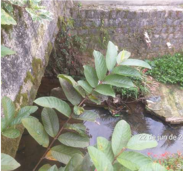
Figura 30: Trecho 56-57, sentido sul, transição do trecho fechado (56) para o trecho aberto (57) .
