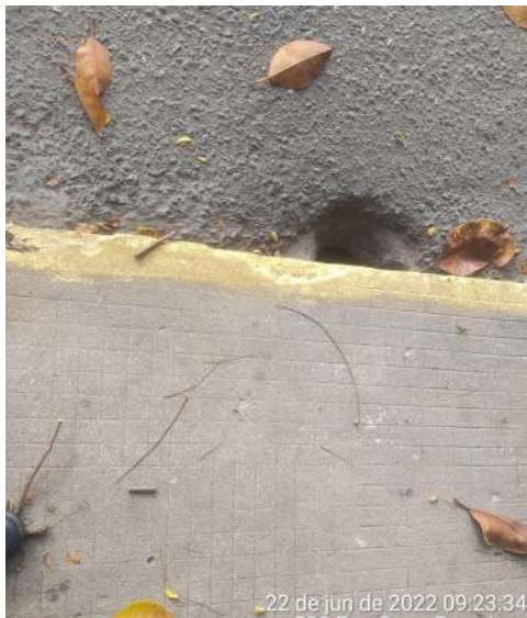
Figura 36: Trecho 65 B, vista superior, trecho tubulado sob via.
