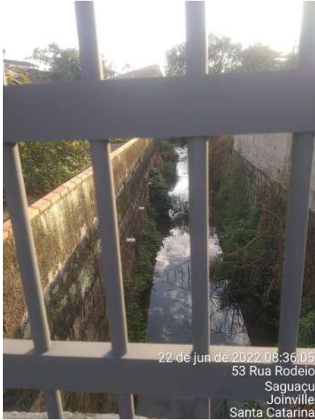
Figura 26: Trecho 49, sentido norte, transição entre trecho aberto (49) e trecho fechado sob via (50).
