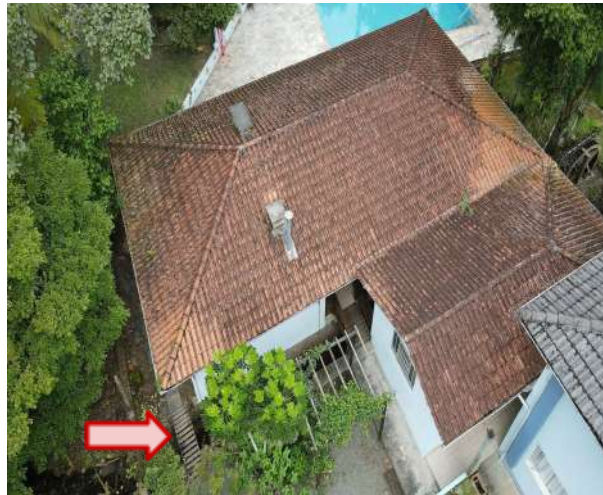
Figura 18: Foto trecho 4B, em direção ao trecho aberto 5A.Trajeto lagoa residência.
