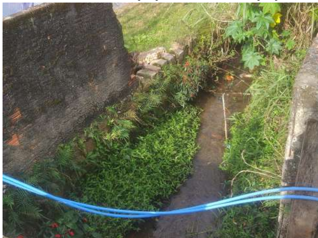
Figura 23: Trecho 33-34, transição entre trecho tubulado sob via (33) e trecho aberto (34).
