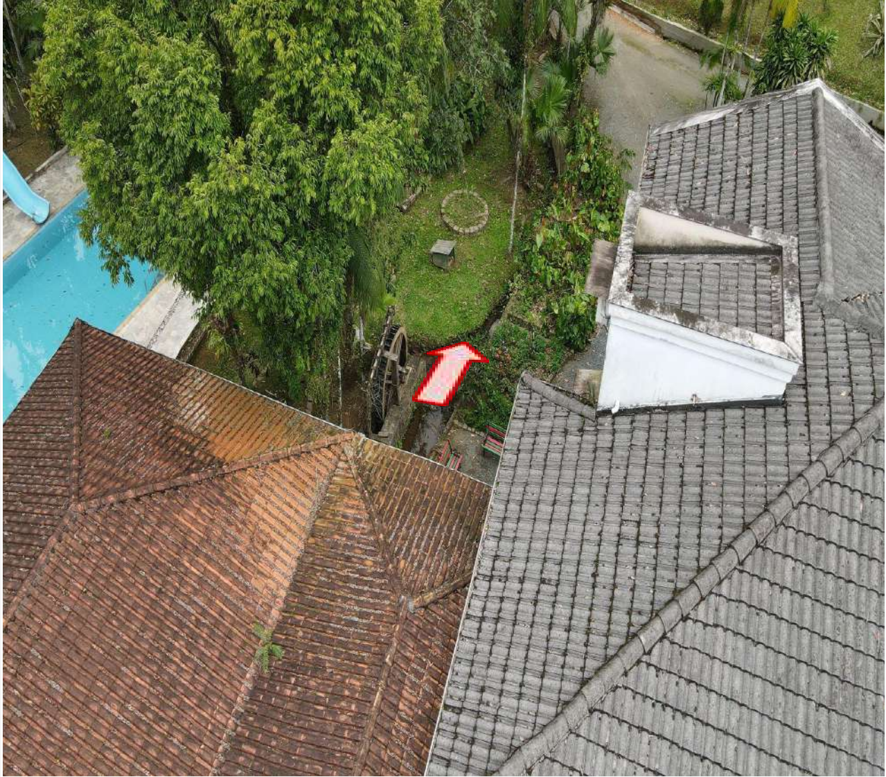
Figura 19: Foto trecho 5A iniciando 5A1, sentido Norte/ Sul. Transição do trecho aberto para trecho tubulado.
