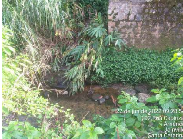
Figura 38: Trecho 68, sentido oeste, trecho aberto com vegetação isolada.
