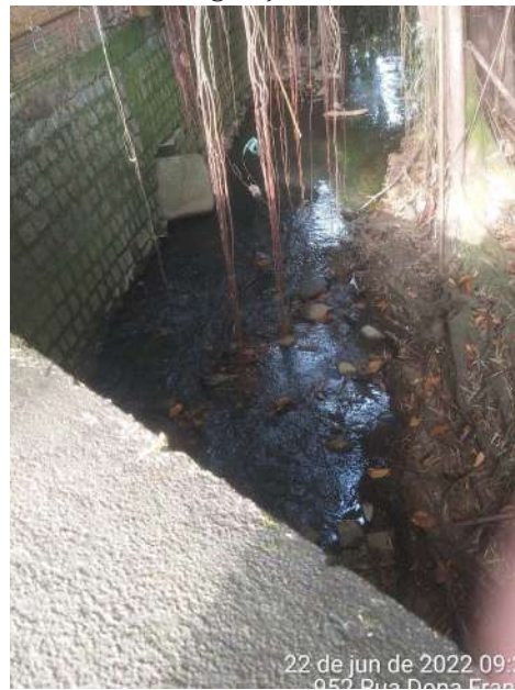
Figura 37: Trecho 66, sentido oeste, trecho aberto com vegetação isolada.
