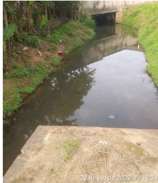
Figura 35: Trecho 64, sentido sul, transição do trecho fechado (63) para o trecho aberto (64) com vegetação isolada.
