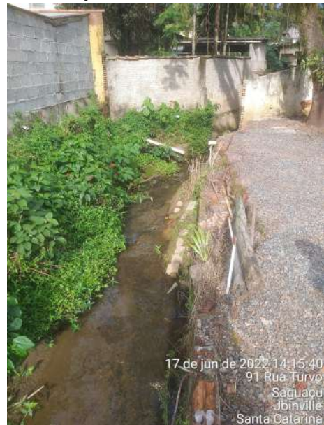
Figura 24: Trecho 35, sentido sul, no detalhe da vista para o trecho aberto.
