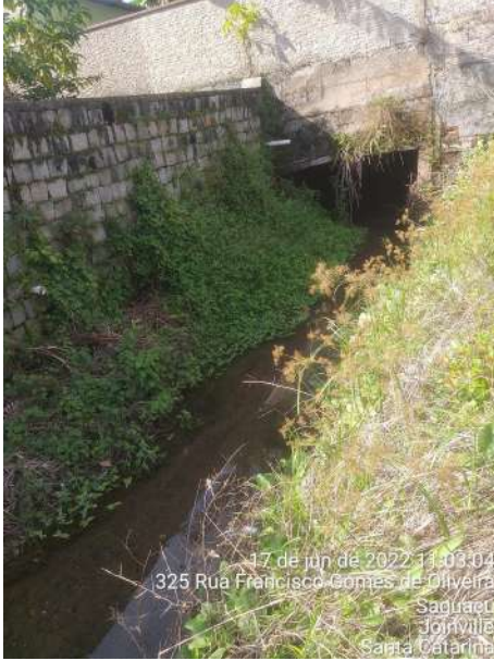
Figura 21: Trecho 30-31, Transição entre trecho aberto (30) e trecho tubulado sob via (31).
