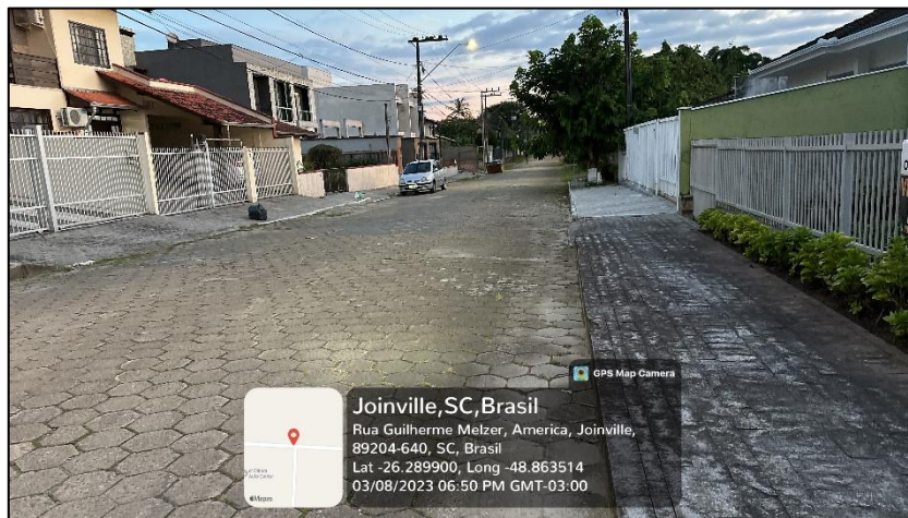
Figura 21 - Trecho 10, tubulado sob via pública.
