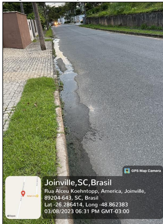
Figura 18 - Trecho 3, tubulado sob via.
