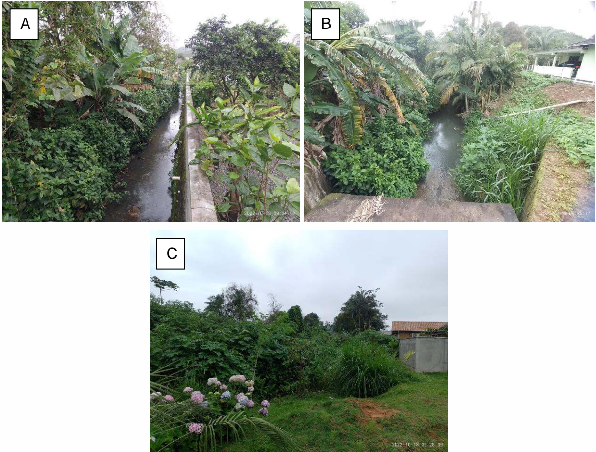
Figura 32: A: Final do trecho 25; B: Tubulação do trecho 26 e início do trecho 27; C: Vegetação sobre o trecho 27, vista do final da rua Clemilda M. de Carvalho. Fonte: Autores.
