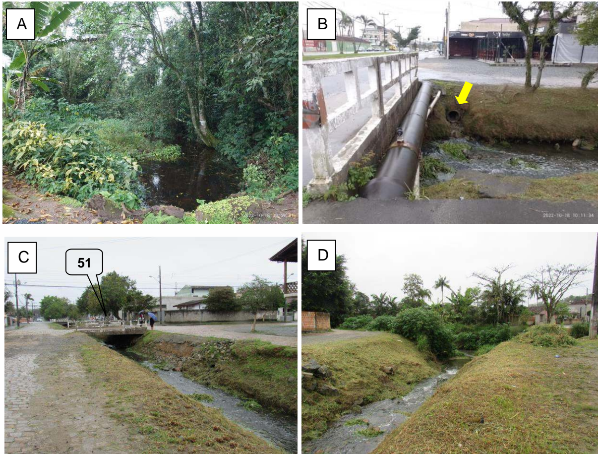
Figura 40: A: Acúmulo de água formado no trecho 46; B: Trecho 49 (fechado sob via) para 50 (aberto) Detalhe para contribuição de drenagem; C: Trecho 52, vista para montante, margem direita.; C: Trecho 52 (foz), vista para jusante.
