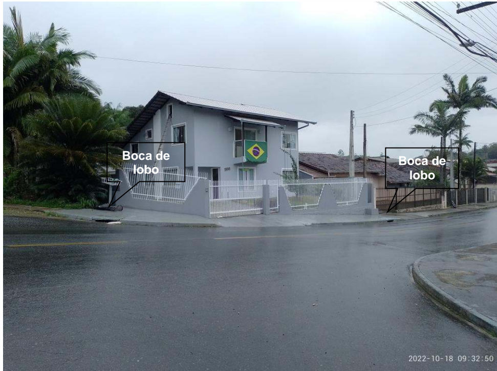
Figura 18: Bocas de lobo e linhas de distribuição de energia na rua Jonecir José Baierski. Fonte: Autores.
