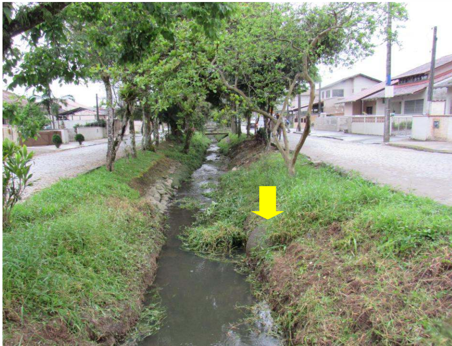
Figura 19: Contribuição de drenagem no rio Célio Gomes, trecho 43, rua dos Radialistas. Fonte: Autores.
