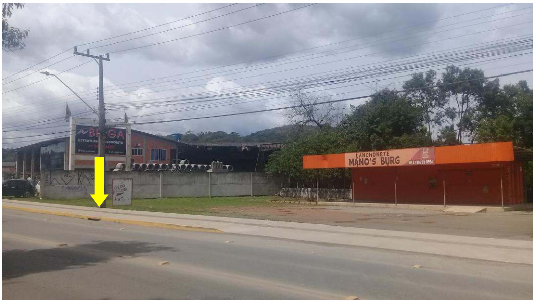
Figura 12: Vista da rua Waldemiro José Borges com indicação da boca de lobo. Fonte: Autores.
