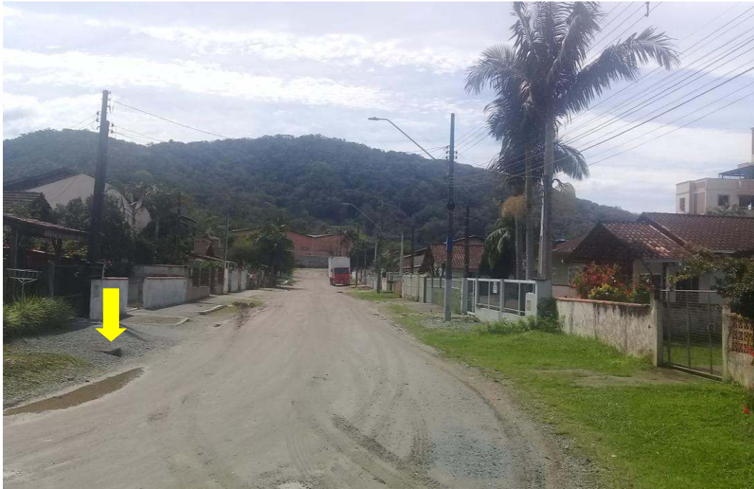
Figura 11: Vista da rua Germano Frederico Timm com indicação da boca de lobo. Fonte: Autores.
