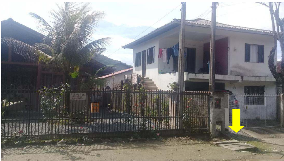
Figura 22: Residências e via nas faixas marginais do corpo d'água tubulado, trechos 4 e 5, com vista a partir da rua Samuel Figueiredo. Indicação de possível tubulação do trecho. Fonte: Autores.
