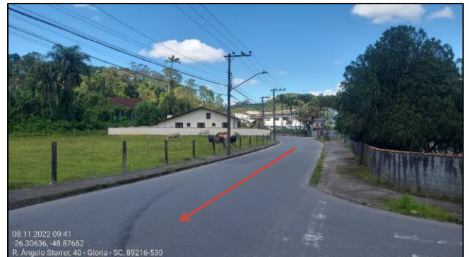
Figura 37 – Localização em campo do trecho 19, evidenciando a localização do corpo d’água tubulado.
