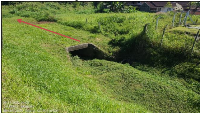
Figura 35 – Localização em campo do trecho 10H, evidenciando a localização do corpo d’água tubulado.
