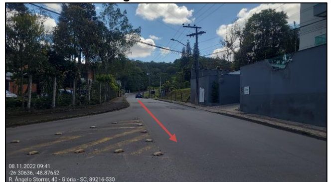
Figura 31 – Localização em campo do trecho 10A e 10B, evidenciando a localização do corpo d'água tubulado.
