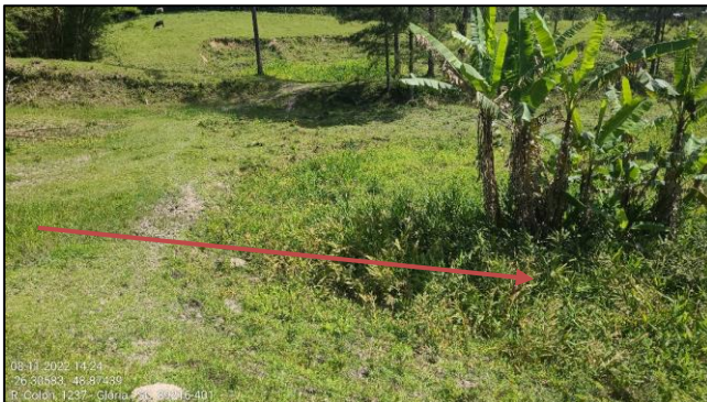
Figura 29 – Localização em campo do trecho 8, evidenciando a localização do corpo d'água tubulado.
