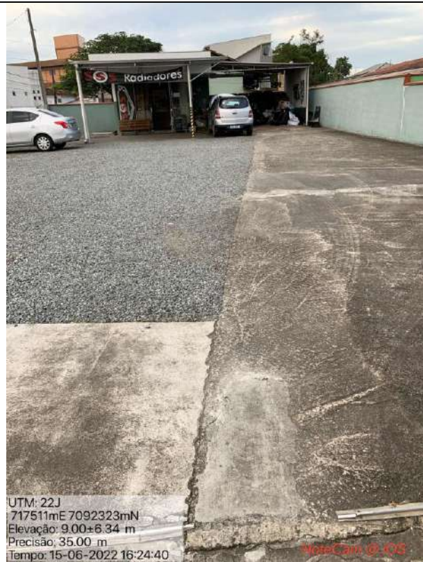
Trecho 64: Trecho tubulado entre lotes
