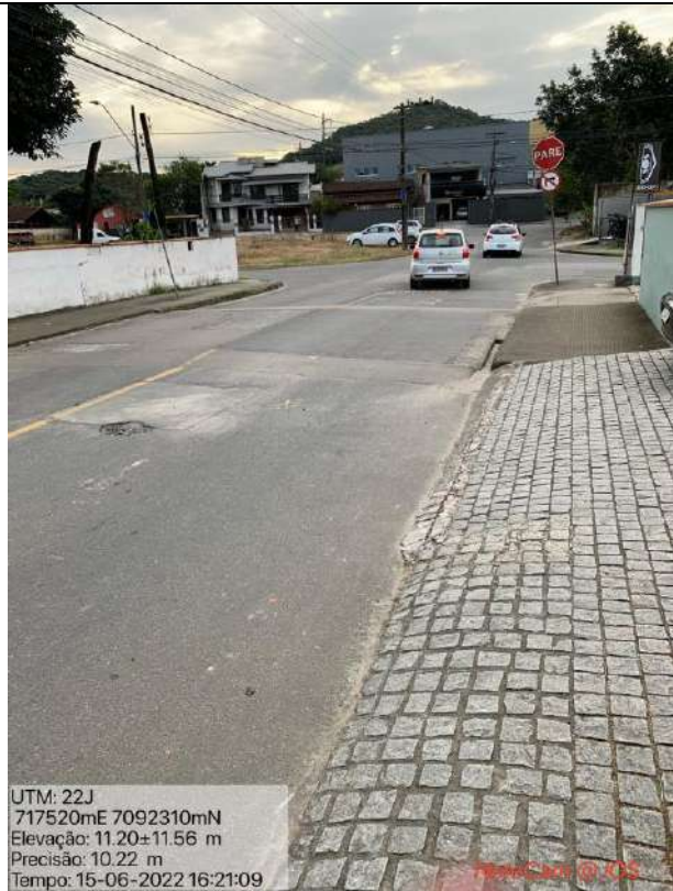
Trecho 63 para trecho 64: Trecho tubulado sob vias públicas para trecho tubulado entre lotes
