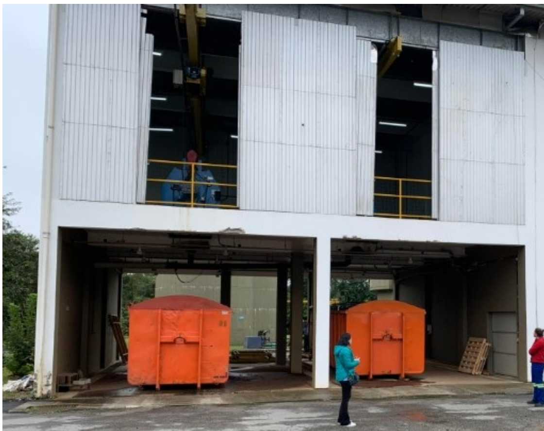
Figura 4 - Caçamba de Lodo - Lodo após processo de desague (média de 20% de Sólidos)
