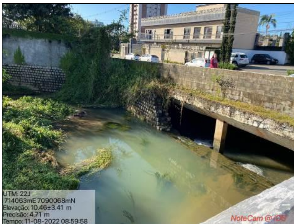
Figura 03: Desvio do Rio Morro no trecho 43
