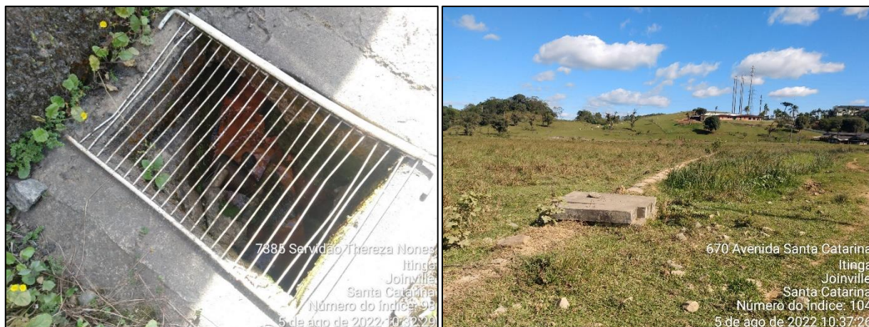
Figura 26: Indicação do trecho 7 (Corpo d'água fechado sob via dentro da AUC) na imagem a esquerda; e trecho 8 (Corpo d'água fechado entre lotes, localizado no Quadrante C ). Fonte: vistoria realizada no dia 05/08/2022 pela equipe técnica da Bioeco.
