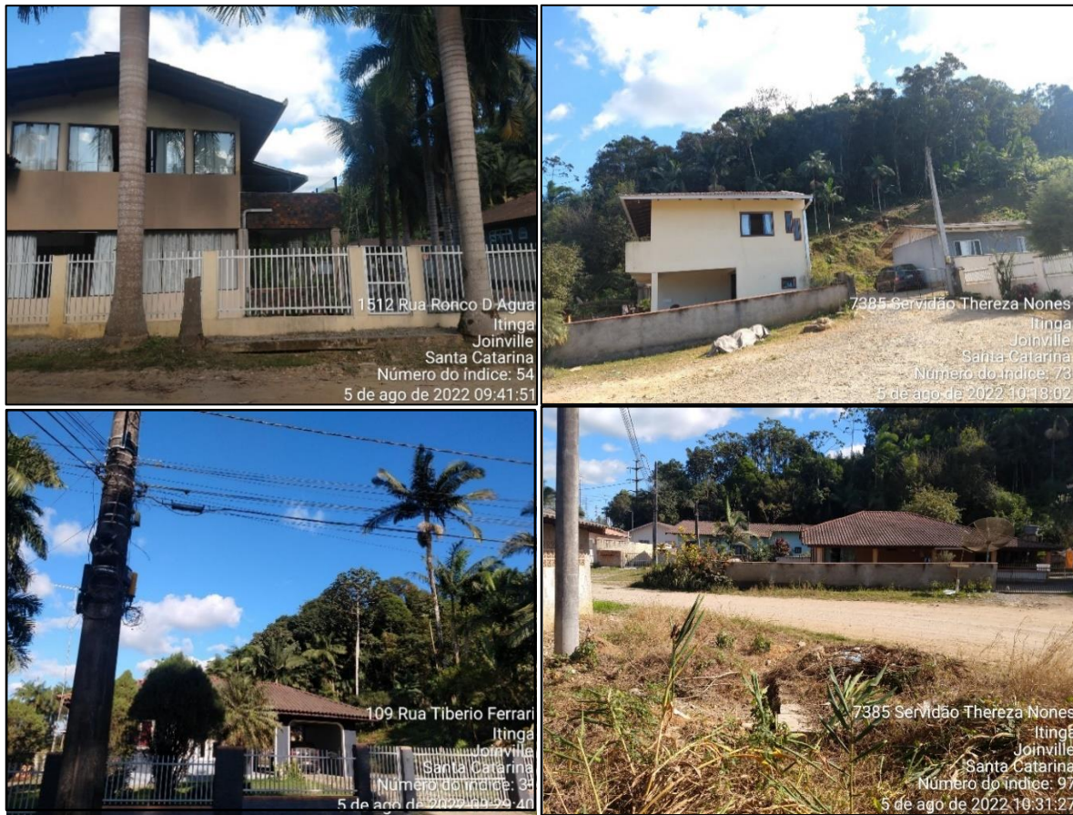
Figura 16: Residências localizadas na área de estudo. Fonte: Vistoria realizada no dia 05/08/2022 pela equipe técnica da Bioeco.
