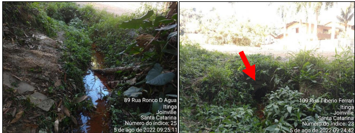
Figura 24. Indicação do trecho 1 (Corpo d'água aberto em vegetação densa) tornando-se o trecho 2 (Corpo d'água fechado sob via fora da AUC), onde é possível ver o início da tubulação na imagem a direita, localizado no Quadrante A . Fonte: vistoria realizada no dia 05/08/2022 pela equipe técnica da Bioeco.
