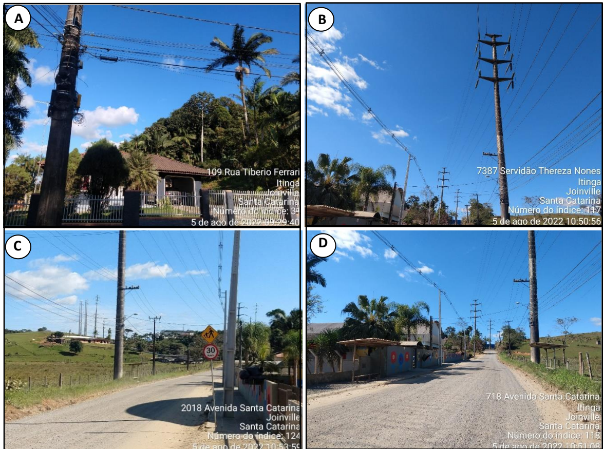
Figura 6: Postes e fiação elétrica presentes na área de estudo. Legenda: A - Registro realizado na Rua Tibério. B – Registro realizado na Servidão Thereza Nunes. C/D - Registro realizado na Avenida Santa Catarina. Fonte: vistoria realizada no dia 05/08/2022 pela equipe técnica da Bioeco.
