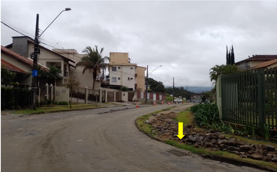
Figura 20: Boca de lobo na rua João Koneski. Fonte: Autores.
