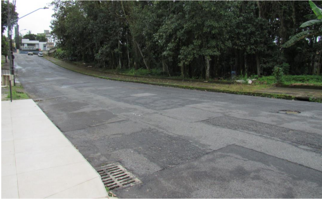
Figura 22: Bocas de lobo na rua João Pessoa. Fonte: Autores.
