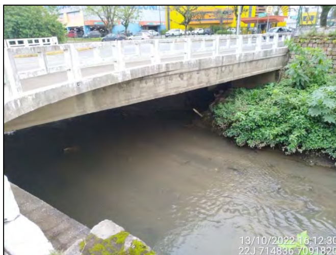
Figura 3.8.1.4: Vista parcial do término do Trecho 1 e início do Trecho 2 no Quadrante A – Jusante. Fonte: OAP (2022).
