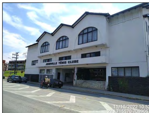
Figura 3.6.6.2: Joinville Tênis Clube (Rua Aubé). Fonte: OAP (2022).
