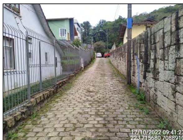
Figura 3.5.1.1.4: Detalhe de pavimentação com intertravado retangular (Rua Sehnem). Fonte: OAP (2022).
