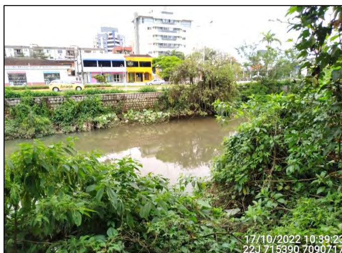
Figura 3.8.3.14: Vista parcial do Trecho 14 no Quadrante C - Montante. Fonte: OAP (2022).
