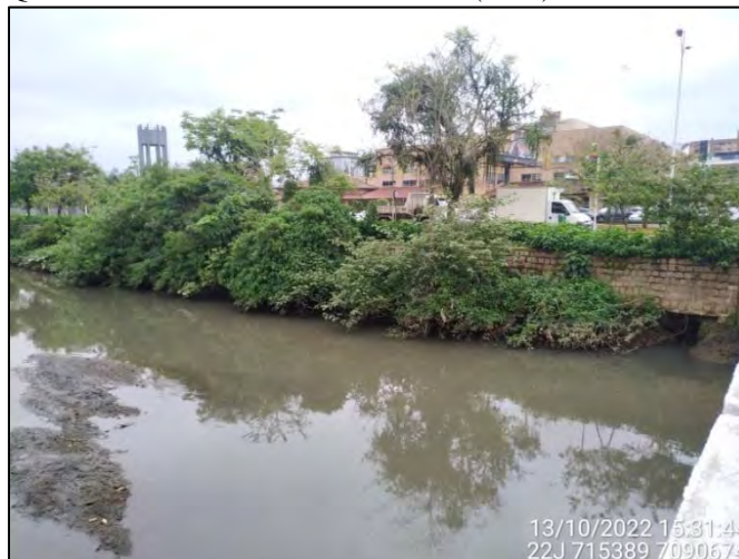
Figura 3.8.3.19: Vista parcial do início do Trecho 16 no Quadrante C – Jusante. Fonte: OAP (2022).
