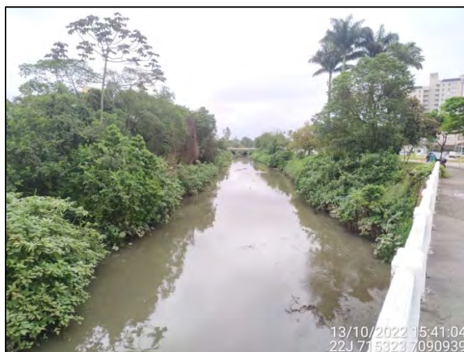
Figura 3.8.2.7: Vista parcial do término do Trecho 7 no Quadrante B – Montante. Fonte: OAP (2022).
