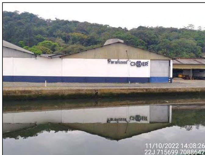
Figura 3.8.8.3: Vista parcial do Trecho 35b no Quadrante H. Fonte: OAP (2022).
