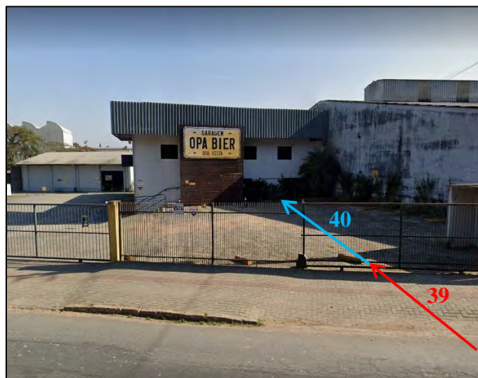
Figura 3.8.8.17: Vista parcial dos Trechos 39 e 40. Posteriormente perfazem os Trechos 41a, 41b, 41c, 42 e 43. Fonte: Google Maps (2022).
