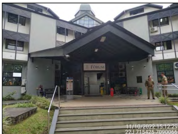
Figura 3.5.1.12.3: Fórum da Comarca de Joinville (Avenida Hermann August Lepper). Fonte: OAP (2022).
