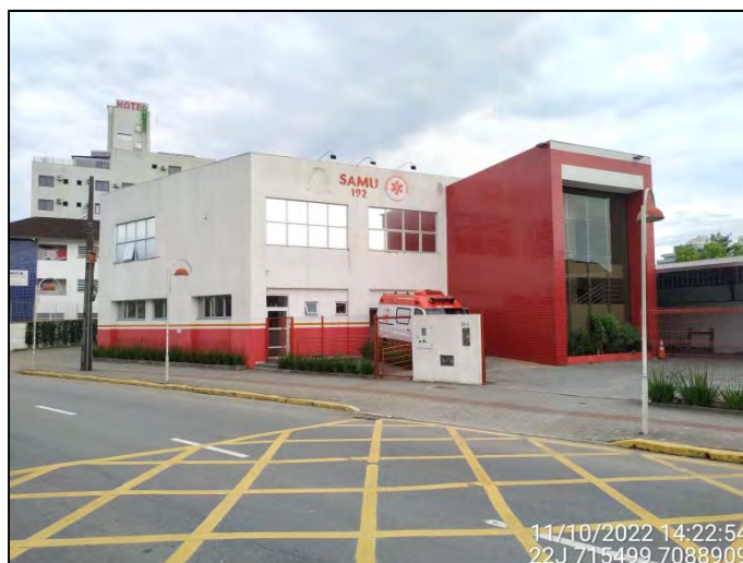
Figura 3.5.1.14.1: Vista parcial da unidade do SAMU (Avenida Doutor Paulo Medeiros). Fonte: OAP (2022).
