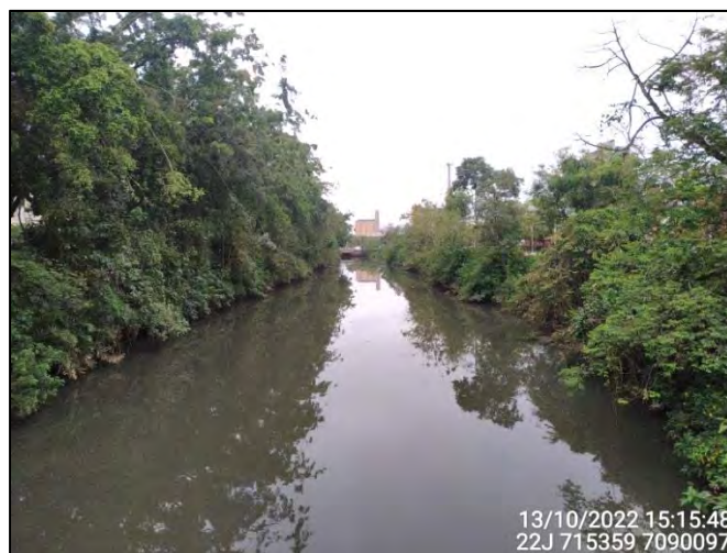
Figura 3.8.4.12: Vista parcial do Trecho 20a no Quadrante D – Jusante. Fonte: OAP (2022).
