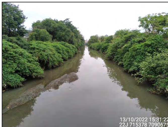
Figura 3.8.3.21: Vista parcial do Trecho 16 no Quadrante C – Jusante. Fonte: OAP (2022).
