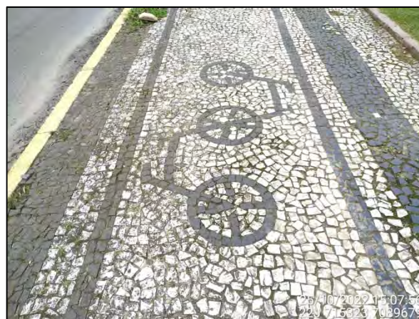
Figura 3.5.1.3.2: Vista parcial da ciclovia na Rua Dona Francisca. Fonte: OAP (2022).
