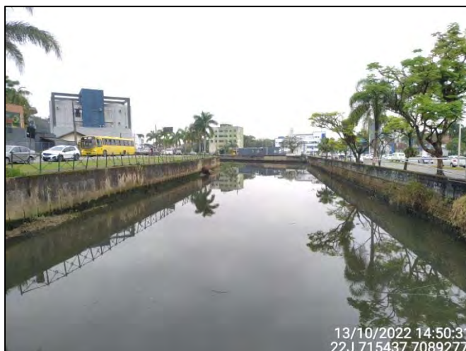
Figura 3.8.6.5: Vista parcial do Trecho 29 no Quadrante F – Jusante. Fonte: OAP (2022).
