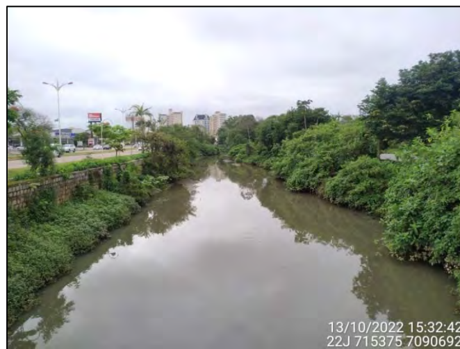
Figura 3.8.3.16: Vista parcial do Trecho 14 no Quadrante C – Montante. Fonte: OAP (2022).
