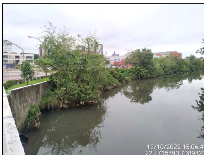
Figura 3.8.5.4: Vista parcial do término do Trecho 21 e início do Trecho 22 no Quadrante E – Montante. Fonte: OAP (2022).
