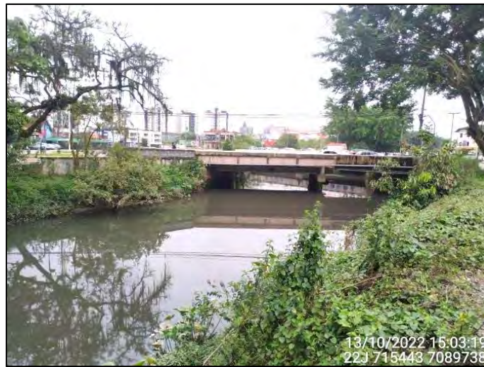
Figura 3.8.5.7: Vista parcial do Trecho 25 no Quadrante E – Montante. Fonte: OAP (2022).
