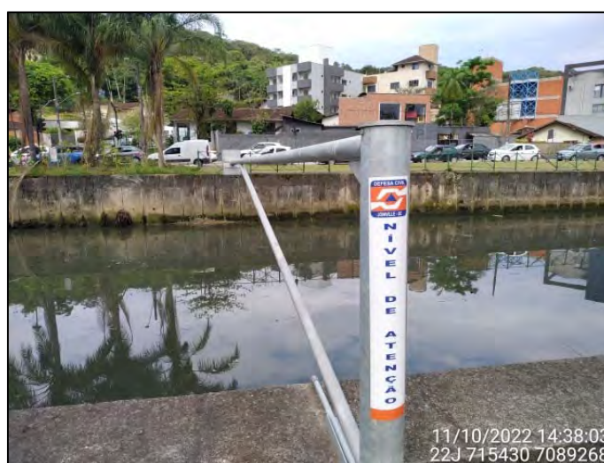
Figura 3.5.1.16.1: Radar de nível de água no rio Cachoeira (Avenida Doutor Albano Schulz). Fonte: OAP (2022).
