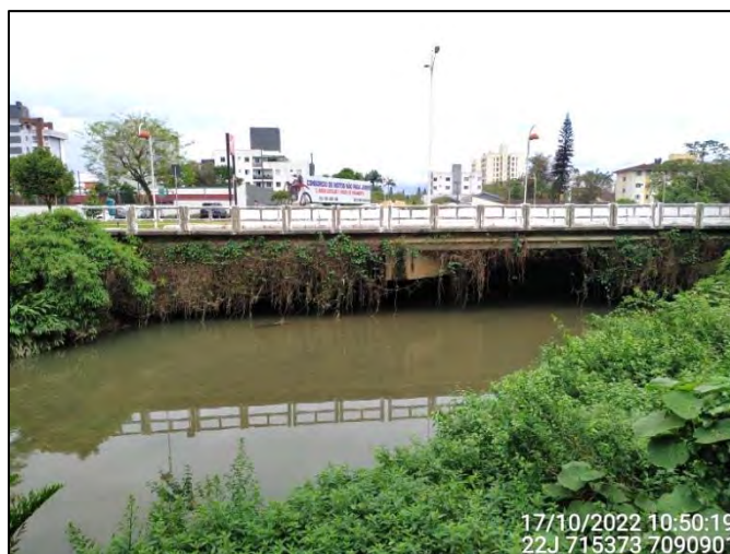
Figura 3.8.3.1: Vista parcial do início do Trecho 9 no Quadrante C – Montante. Fonte: OAP (2022).
