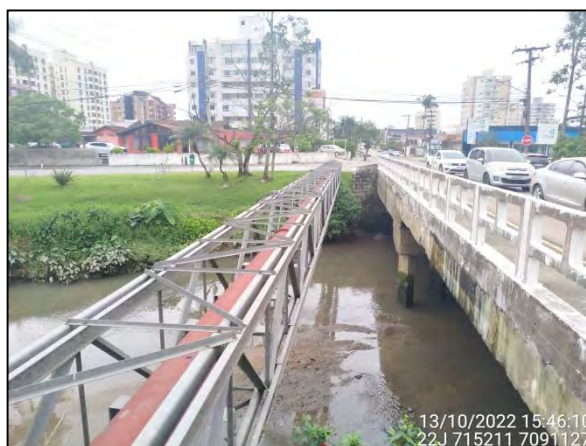
Figura 3.5.1.8.2: Vista parcial de tubulação ativa de recalque de esgoto com 400 mm (Rua Padre Antônio Vieira). Fonte: SIMGeo (2022) e OAP (2022).
