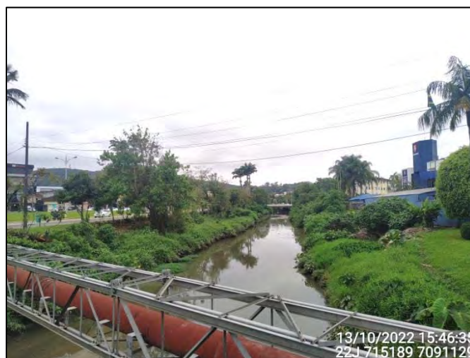
Figura 3.8.2.3: Vista parcial do Trecho 5 no Quadrante B – Montante. Fonte: OAP (2022).
