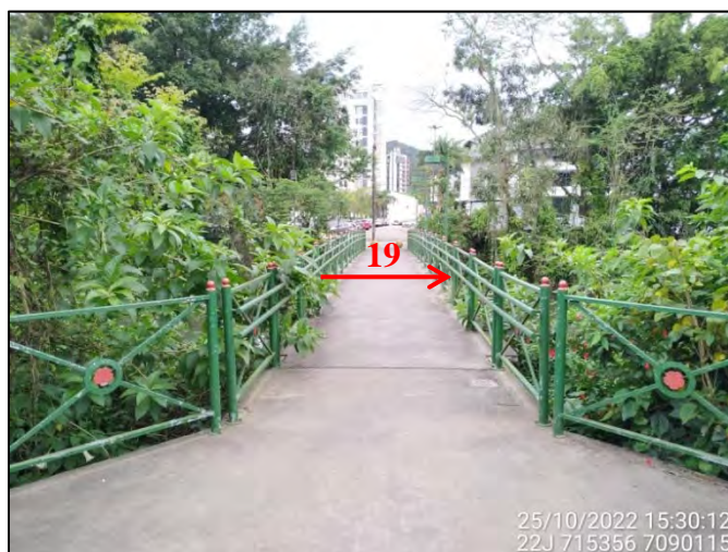
Figura 3.8.4.11: Vista parcial do Trecho 19 no Quadrante D. Fonte: OAP (2022).
