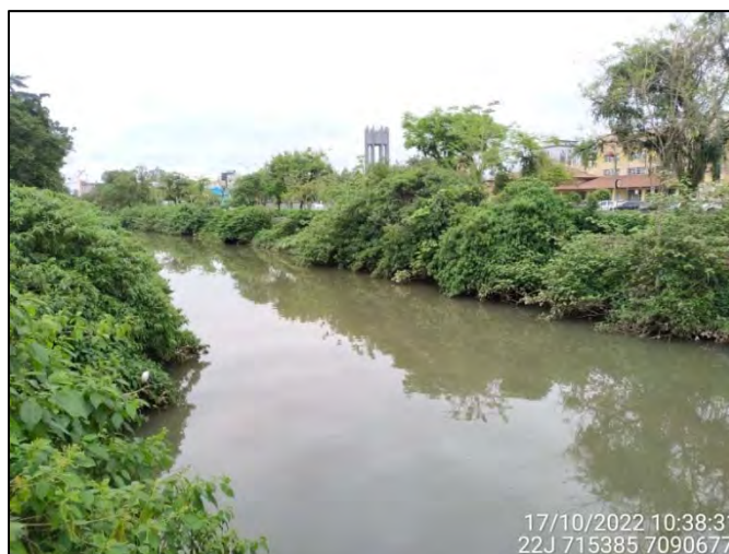
Figura 3.8.3.20: Vista parcial do Trecho 16 no Quadrante C – Jusante. Fonte: OAP (2022).
