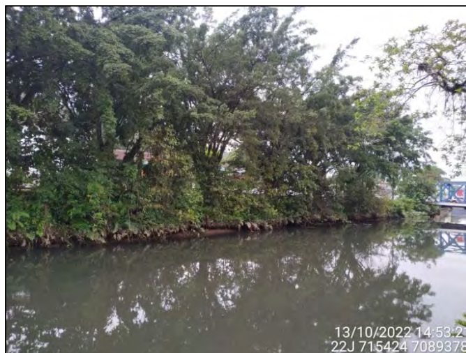
Figura 3.8.6.2: Vista parcial do Trecho 27 no Quadrante F – Jusante. Fonte: OAP (2022).
