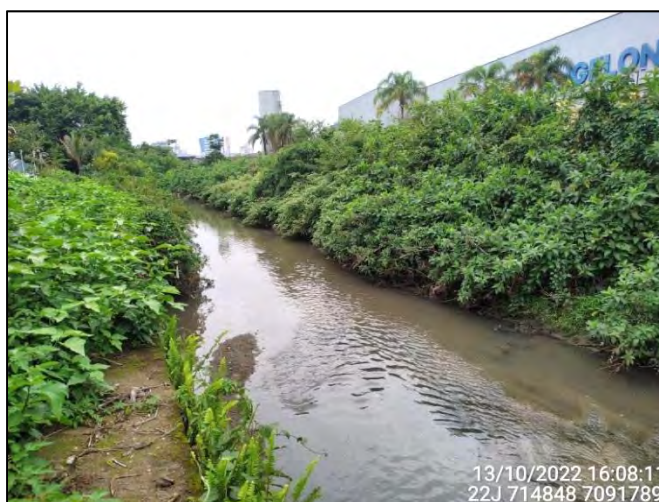
Figura 3.8.1.6: Vista parcial do Trecho 3 no Quadrante A – Jusante. Fonte: OAP (2022).
