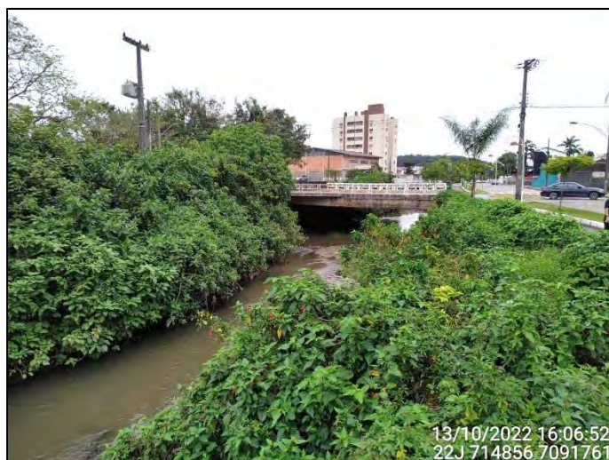
Figura 3.8.1.7: Vista parcial do Trecho 3 no Quadrante A – Montante. Fonte: OAP (2022).
