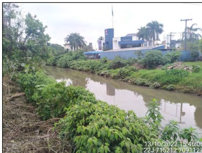
Figura 3.8.2.5: Vista parcial do Trecho 7 no Quadrante B – Jusante. Fonte: OAP (2022).
