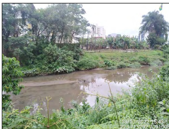
Figura 3.8.2.6: Vista parcial do Trecho 7 no Quadrante B – Montante. Fonte: OAP (2022).
