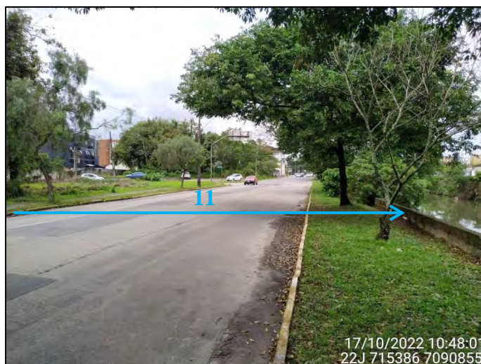
Figura 3.8.3.7: Vista parcial do Trecho 11 no Quadrante C – Montante. Fonte: OAP (2022).
