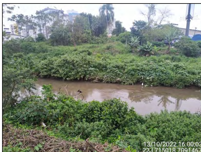
Figura 3.8.1.12: Vista parcial do Trecho 4 no Quadrante A – Jusante. Fonte: OAP (2022).
