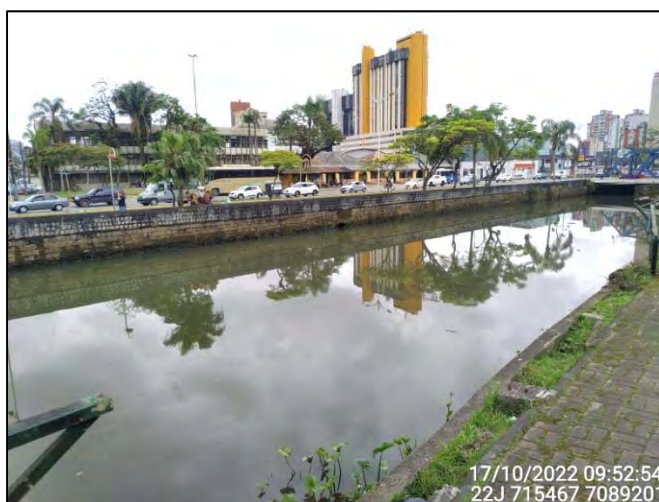
Figura 3.8.6.6: Vista parcial do Trecho 29 no Quadrante F – Montante. Fonte: OAP (2022).
