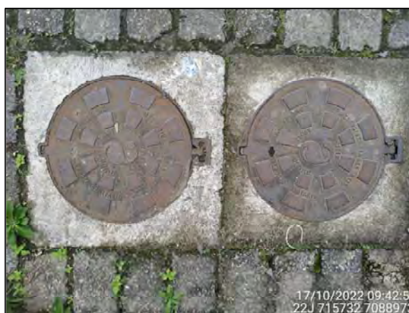
Figura 3.5.1.8.4: Caixas de inspeção de esgoto (Rua Sehnem). Fonte: OAP (2022).
