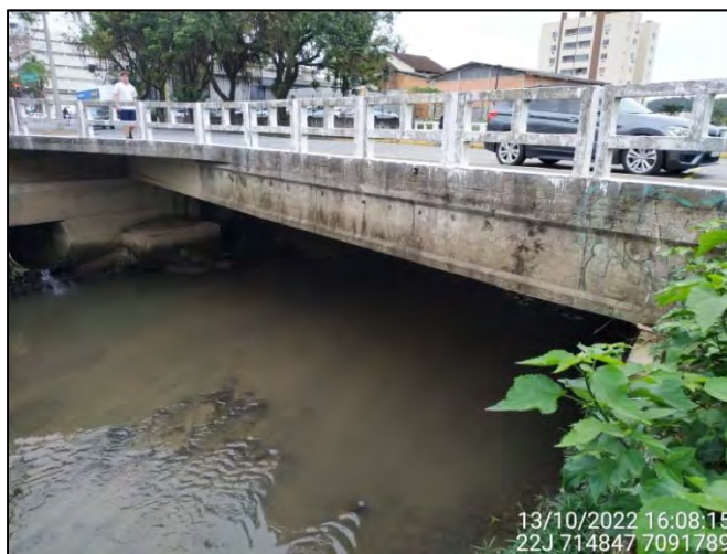
Figura 3.8.1.5: Vista parcial do término do Trecho 2 e início do Trecho 3 no Quadrante A – Montante. Fonte: OAP (2022).
