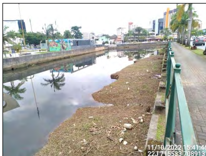
Figura 3.8.6.11: Vista parcial do Trecho 31 no Quadrante F - Montante. Fonte: OAP (2022).
