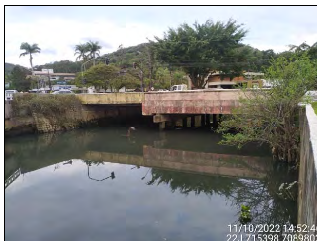
Figura 3.8.5.5: Vista parcial do Trecho 23 e início do Trecho 24 no Quadrante E – Jusante. Fonte: OAP (2022).
