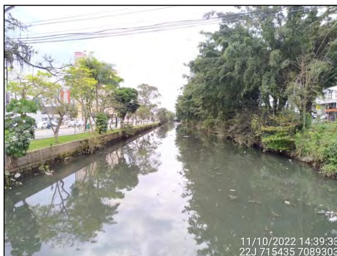
Figura 3.8.6.3: Vista parcial do Trecho 27 no Quadrante F – Montante. Fonte: OAP (2022).
