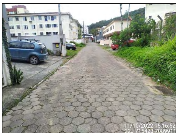
Figura 3.5.1.1.3: Detalhe de pavimentação com intertravado sextavado (Rua Carlos Klinger). Fonte: OAP (2022).
