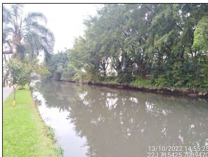
Figura 3.8.5.13: Vista parcial do término do Trecho 26b no Quadrante E – Jusante. Fonte: OAP (2022).
