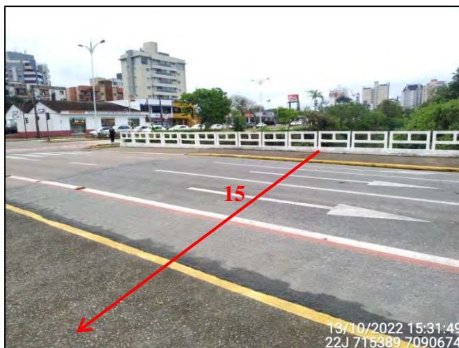
Figura 3.8.3.18: Vista parcial do início do Trecho 15 no Quadrante C – Montante. Fonte: OAP (2022).
