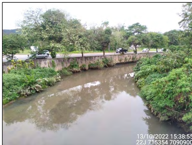
Figura 3.8.3.2: Vista parcial do Trecho 9 no Quadrante C – Jusante. Fonte: OAP (2022).
