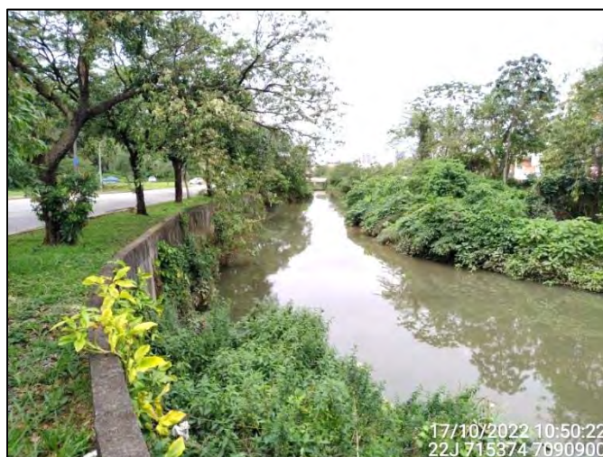
Figura 3.8.3.3: Vista parcial do Trecho 9 no Quadrante C – Jusante. Fonte: OAP (2022).
