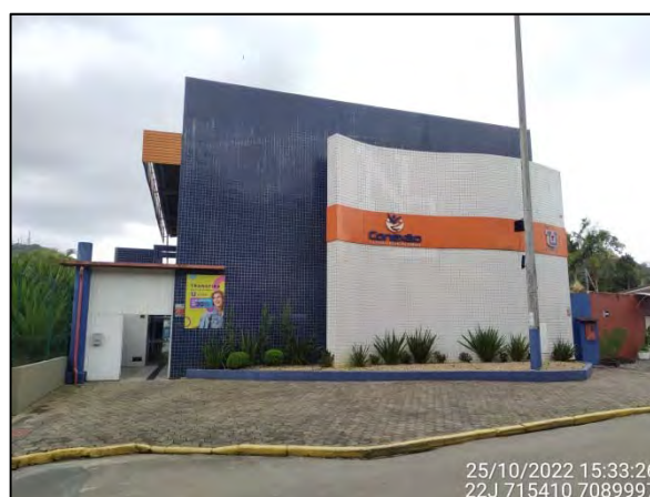
Figura 3.5.1.15.2: Vista parcial do Colégio Conexão Joinville (via de acesso ao Fórum de Joinville). Fonte: OAP (2022).
