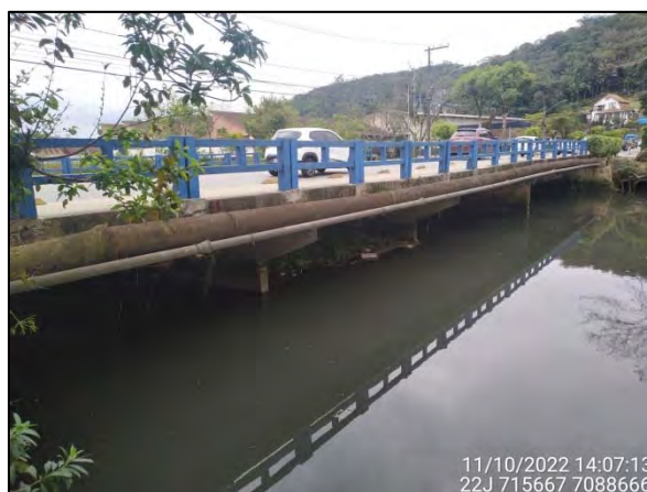
Figura 3.5.1.7.1: Ponte na Rua Carlos Frederico Adolfo Schneider que perpassa uma tubulação ativa de distribuição de água Fonte: SIMGeo (2022) e OAP (2022).
