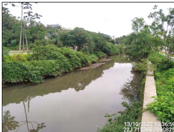
Figura 3.8.3.10: Vista parcial do Trecho 12 no Quadrante C – Jusante. Fonte: OAP (2022).
