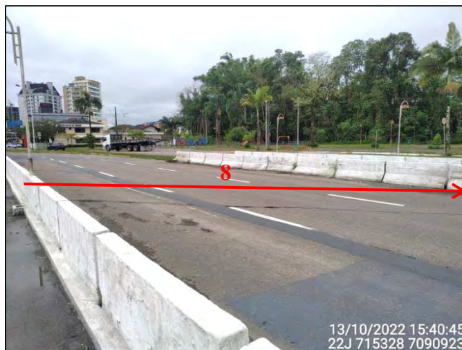
Figura 3.8.2.8: Vista parcial do Trecho 8 no Quadrante B – Jusante. Fonte: OAP (2022).
