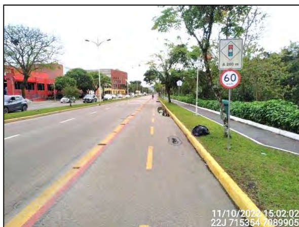
Figura 3.5.1.3.1: Vista parcial da ciclovia na Avenida José Vieira. Fonte: OAP (2022).
