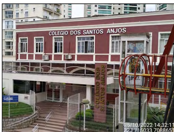
Figura 3.5.1.15.1: Vista parcial do Colégio dos Santos Anjos (Avenida Juscelino Kubitschek). Fonte: OAP (2022).
