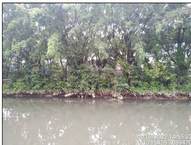
Figura 3.8.6.1: Vista parcial do início do Trecho 27 no Quadrante F. Fonte: OAP (2022).
