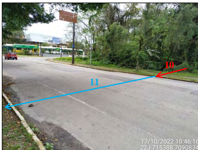
Figura 3.8.3.6: Vista parcial do Trecho 10 (seta em vermelho) e do Trecho 11 (seta em azul) no Quadrante C – Montante. Fonte: OAP (2022).
