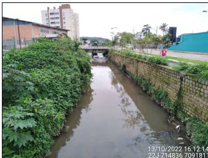
Figura 3.8.1.2: Vista parcial do Trecho 1 no Quadrante A - Montante. Fonte: OAP (2022).
