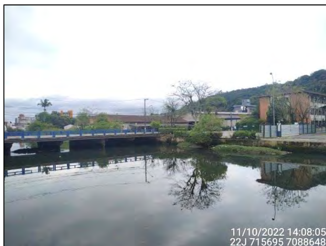
Figura 3.8.8.2: Vista parcial dos Trechos 35a e 35b no Quadrante H - Montante. Fonte: OAP (2022).
