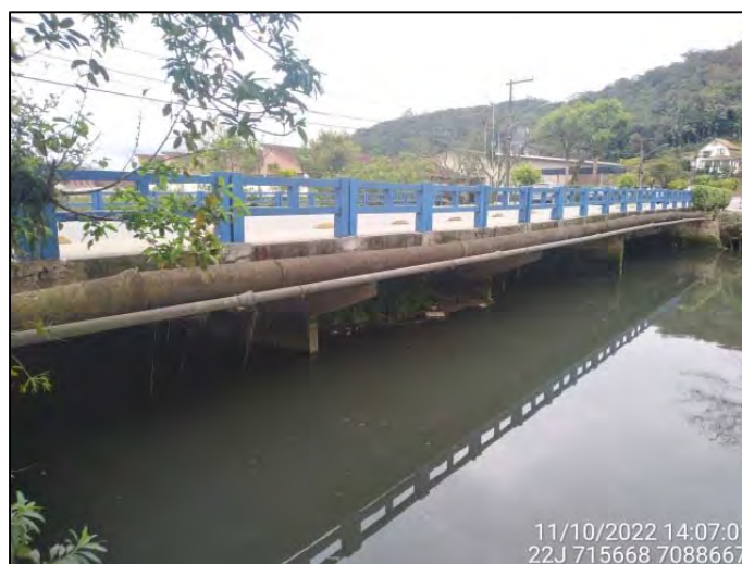
Figura 3.8.8.1: Vista parcial do Trecho 35a no Quadrante H - Montante. Fonte: OAP (2022).
