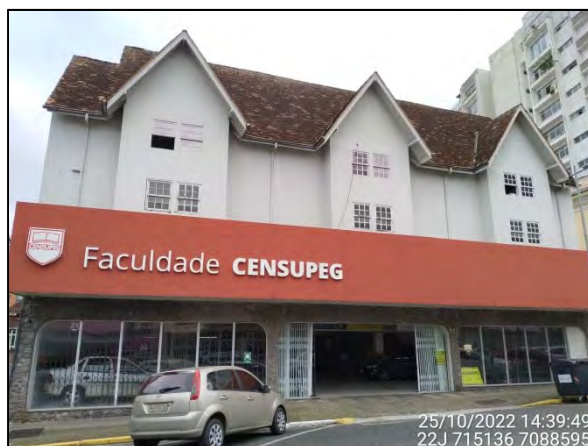
Figura 3.5.1.15.3: Vista parcial da Faculdade Censupeg (Avenida Juscelino Kubitschek). Fonte: OAP (2022).
