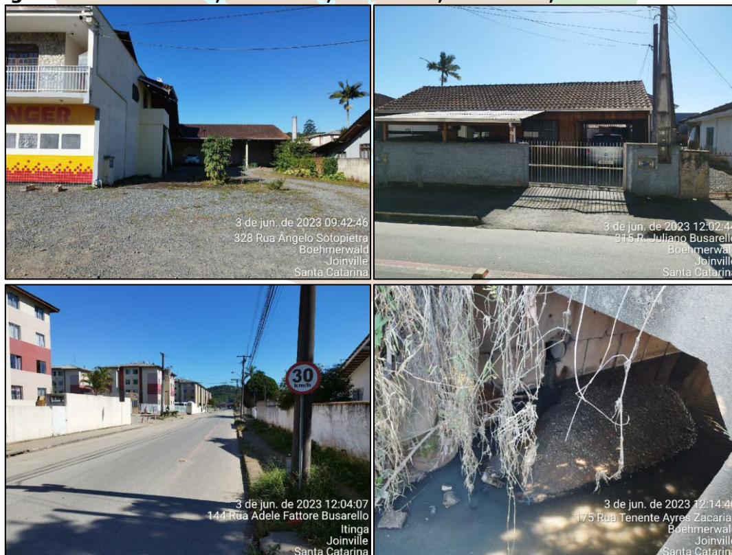
Figura 26 - Em ordem, trecho 16, trecho 16, trecho 17, final do trecho 17.
