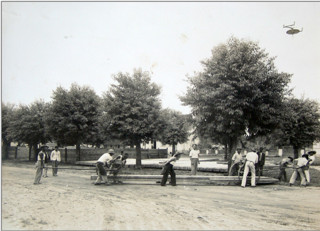
Figura 03. Ponte do Rio Cachoeira, anos 40. Fonte: Arquivo Histórico-PMJ.
