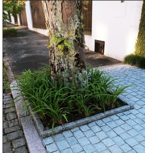
Figura 23. Exemplo de área permeável.
