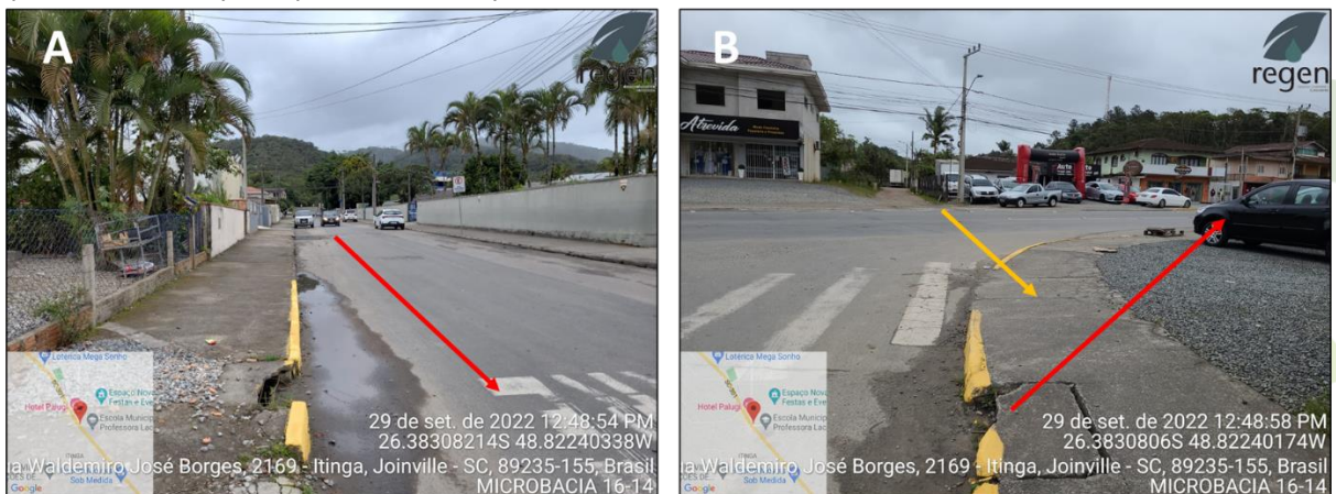
Figura 24. Registros fotográficos dos techos 14 e 5. Foto A: direção do corpo d'água tubulado do trecho 14 (seta vermelha). Foto B: Encontro dos corpos hídricos tubulados do trecho 14 (seta vermelha) e 5 (seta amarela) Fonte: primária, 2022.
