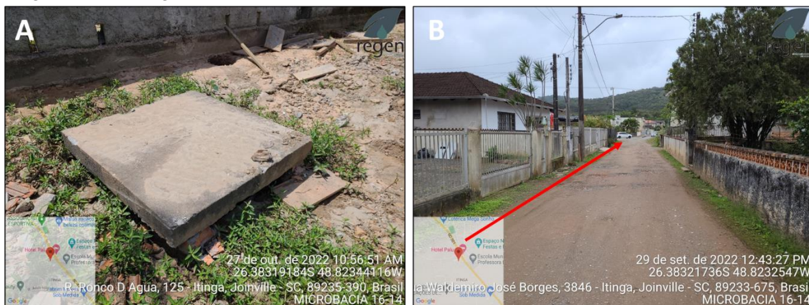
Figura 18. Registro fotográfico do trecho 4. Foto A: Vista da caixa de saída conforme base de dados do simgeo. Foto B: trajeto da tubulação na via particular conforme base de dados do simgeo. Fonte: Regen, 2022.
