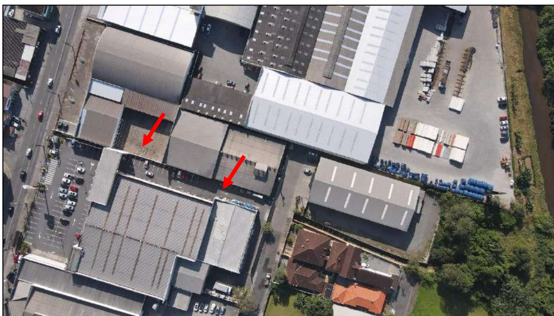
Foto 70: Imagem aérea demonstrando a localização do trecho 16 (trecho tubulado/galeria fechada) em relação ao entorno (04/07/2022).
