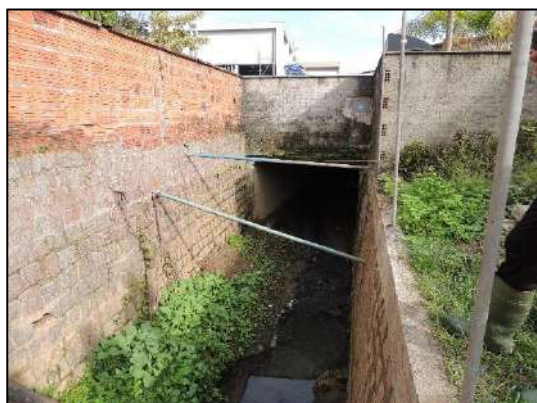
Foto 30: Quadrante G (trecho 17) - Galeria de grande dimensão e trecho aberto (Rua Marechal Floriano).
