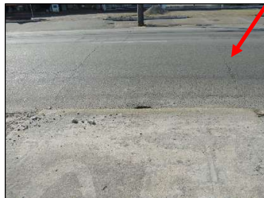
Foto 67: Indicativo da passagem da galeria sob pavimentação asfáltica no trecho 15 (01/08/2022).
