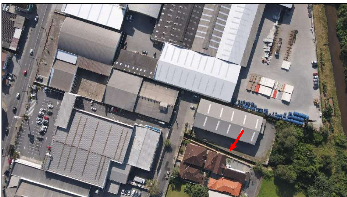
Foto 73: Imagem aérea demonstrando a localização do trecho 17 (trecho canalizado em galeria aberta) em relação ao entorno (04/07/2022).
