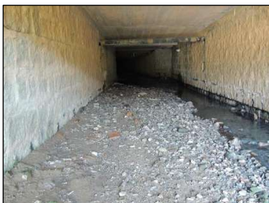
Foto 54: Visão interna do final da galeria no trecho 7 (01/08/2022).
