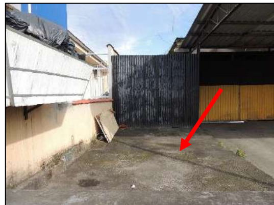
Foto 65: Trecho 15 - início da galeria fechada (01/08/2022).
