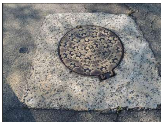
Foto 27: Quadrante B (trecho 04) - Caixa de inspeção (Rua Orleans).
