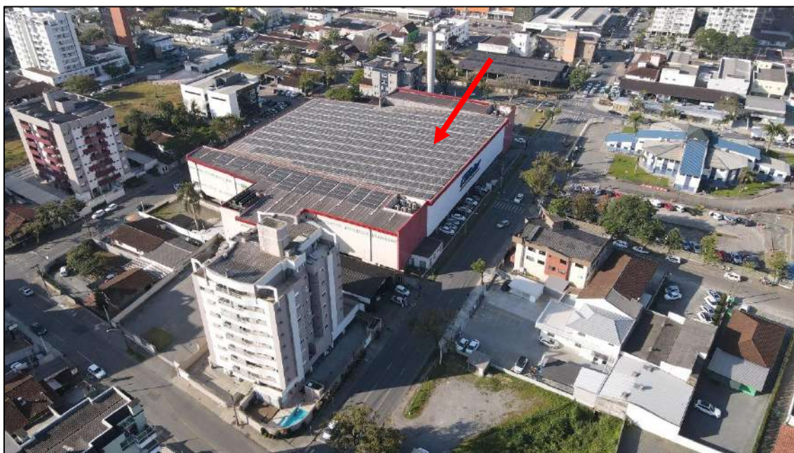
Foto 63: Imagem aérea demonstrando a localização do trecho 10 em relação ao entorno (04/07/2022).
