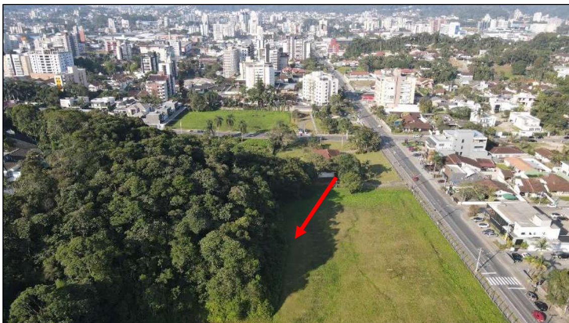
Foto 46: Imagem aérea demonstrando a localização do trecho 3 em relação ao entorno (04/07/2022).
