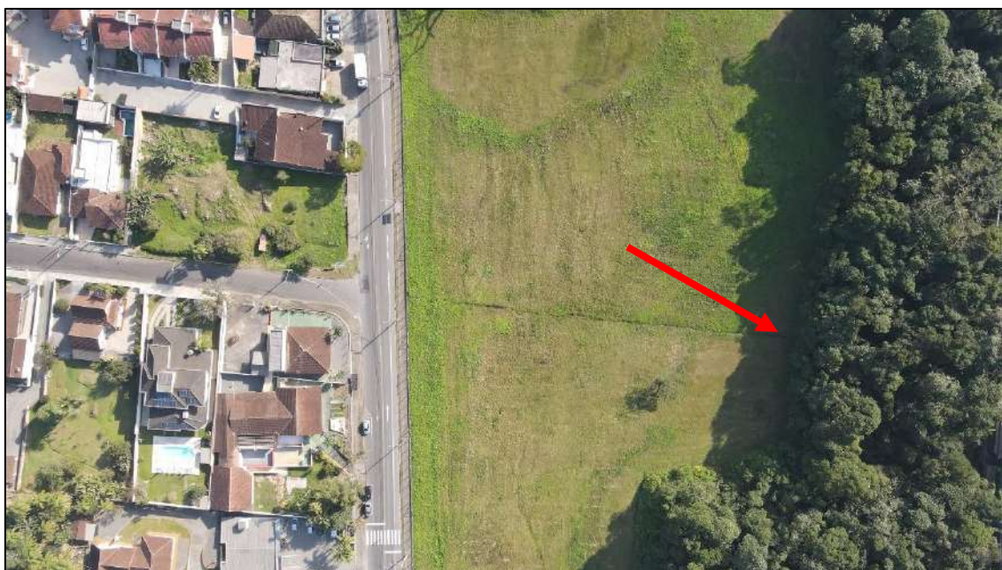
Foto 43: Imagem aérea demonstrando a localização do trecho 2 em relação ao entorno (04/07/2022).
