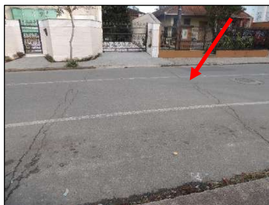
Foto 55: Indicativo da passagem da galeria sob pavimentação asfáltica no trecho 7 (01/08/2022).
