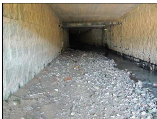
Foto 29: Quadrante D (trecho 08) - Galeria de grande dimensão (Rua Machado de Assis esquina com Rua Almirante Barroso).
