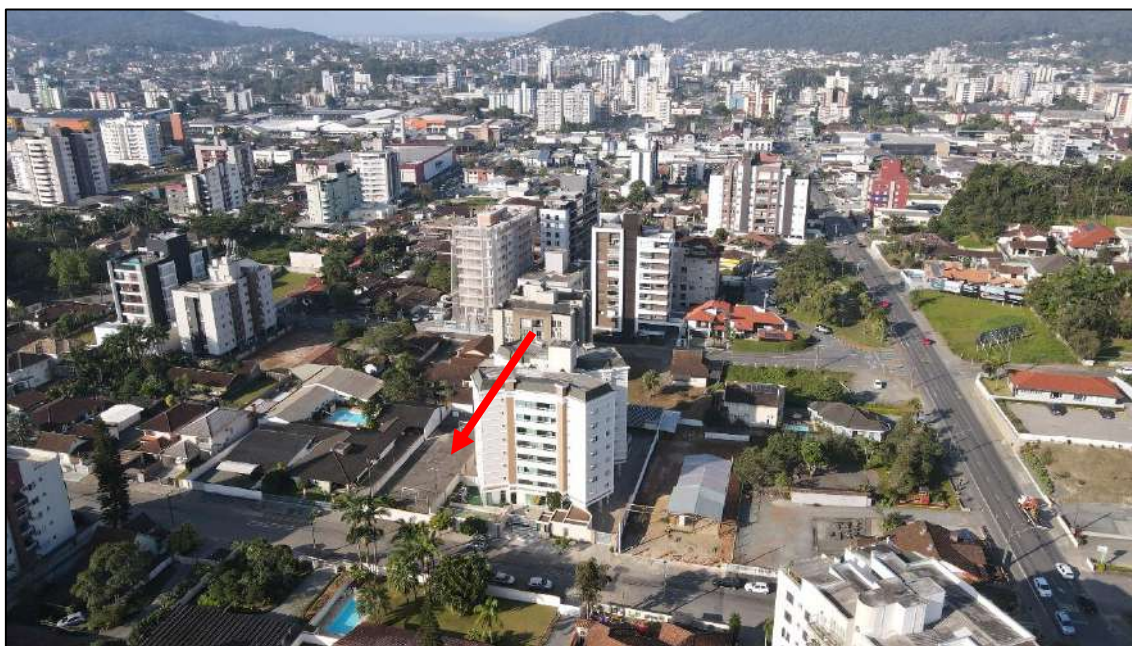
Foto 52: Imagem aérea demonstrando a localização do trecho 6 em relação ao entorno (04/07/2022).
