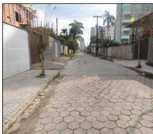
Foto 08: Quadrante D (trecho 07) - Detalhe da pavimentação: intertravado sextavado e asfáltico na localização da galeria.
