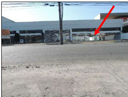
Foto 66: Trecho 15 - parte tubulado sob a via e parte sob as construções (01/08/2022).
