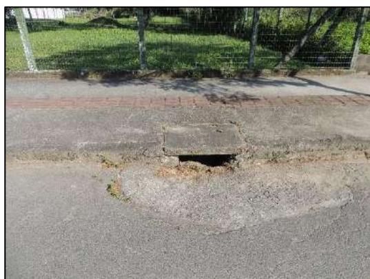
Foto 26: Quadrante B (trecho 04) - Boca-de-lobo (Rua Orleans).
