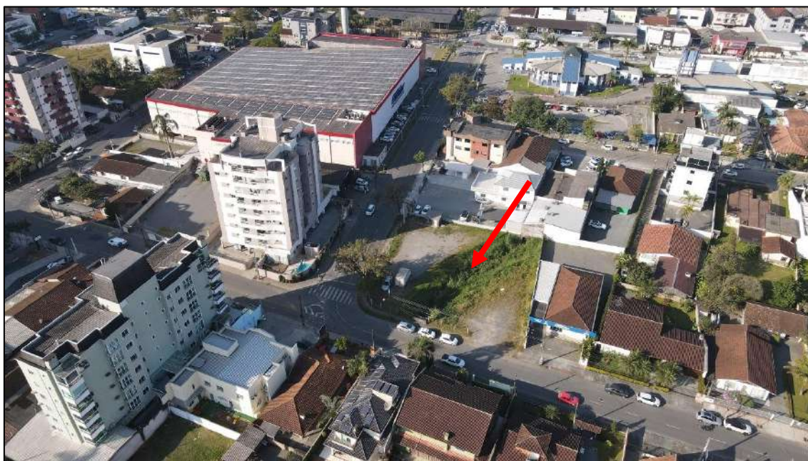
Foto 61: Imagem aérea demonstrando a localização do trecho 8 em relação ao entorno (04/07/2022).
