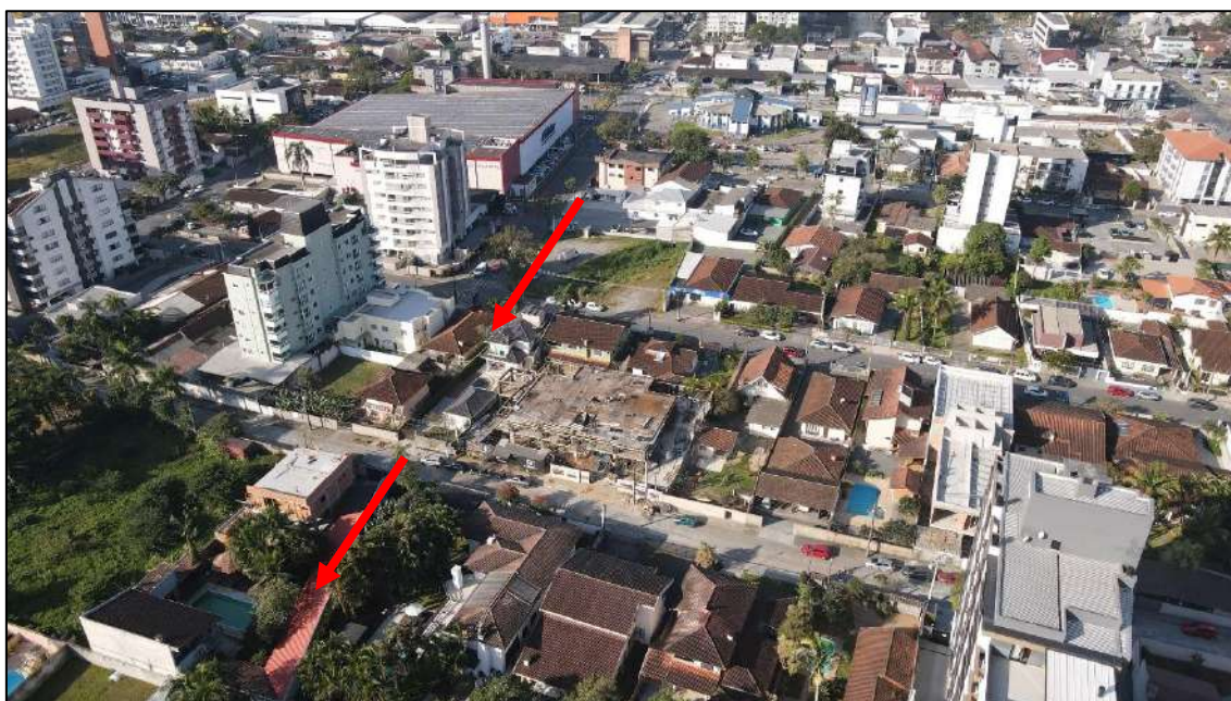
Foto 56: Imagem aérea demonstrando a localização do trecho 7 em relação ao entorno (04/07/2022).
