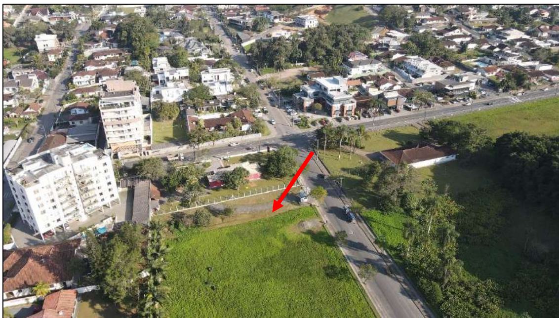
Foto 50: Imagem aérea demonstrando a localização do trecho 4 em relação ao entorno (04/07/2022).
