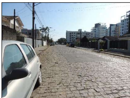
Foto 09: Quadrante C (trecho 06) - Detalhe da pavimentação com paralelepípedo.
