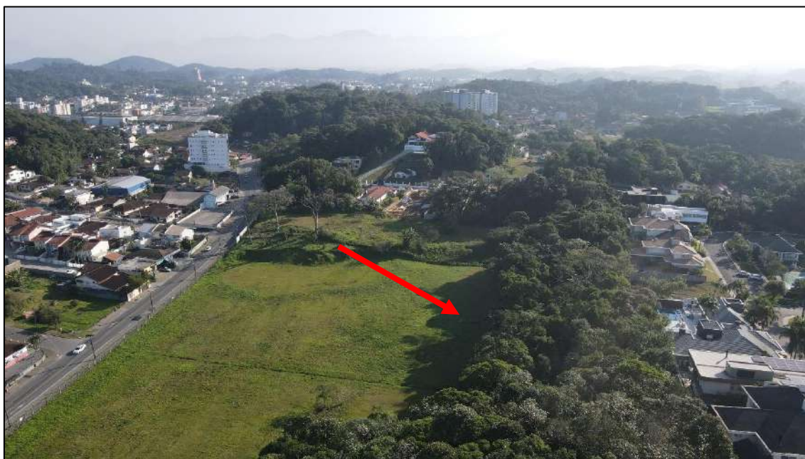
Foto 44: Imagem aérea demonstrando a localização do trecho 2 em relação ao entorno (04/07/2022).
