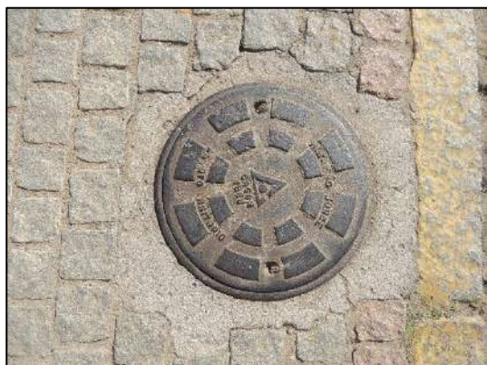
Foto 24: Poço de visita na calçada (Rua Visconde de Mauá).
