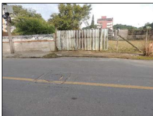
Foto 85: Quadrante D (trecho 07) – Detalhe do pavimento, rede de esgoto, imóveis.
