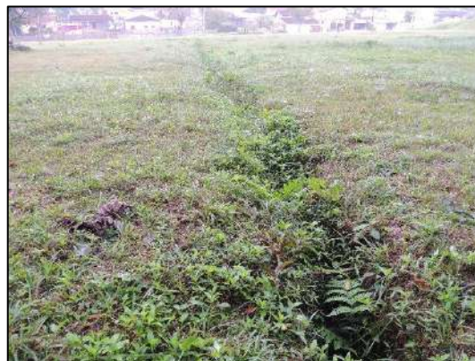
Foto 88: Quadrante A (trecho 02) – Drenagem no imóvel.
