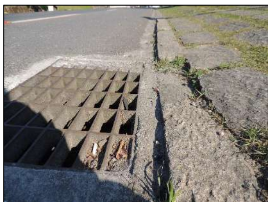
Foto 28: Sarjeta e caixa de captação com grelha (Rua Benjamin Constant).
