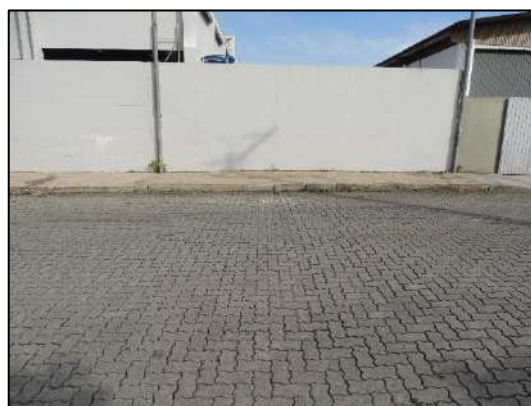
Foto 10: Quadrante G (trecho 16 e 17) - Detalhe do pavimento intertravado.
