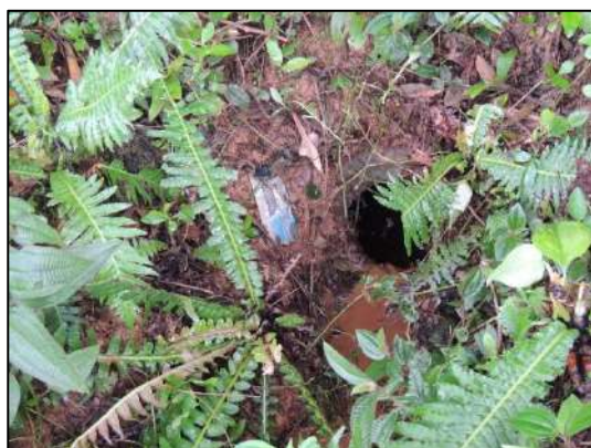
Foto 91: Quadrante A (trecho 02) – Tubulação de drenagem.
