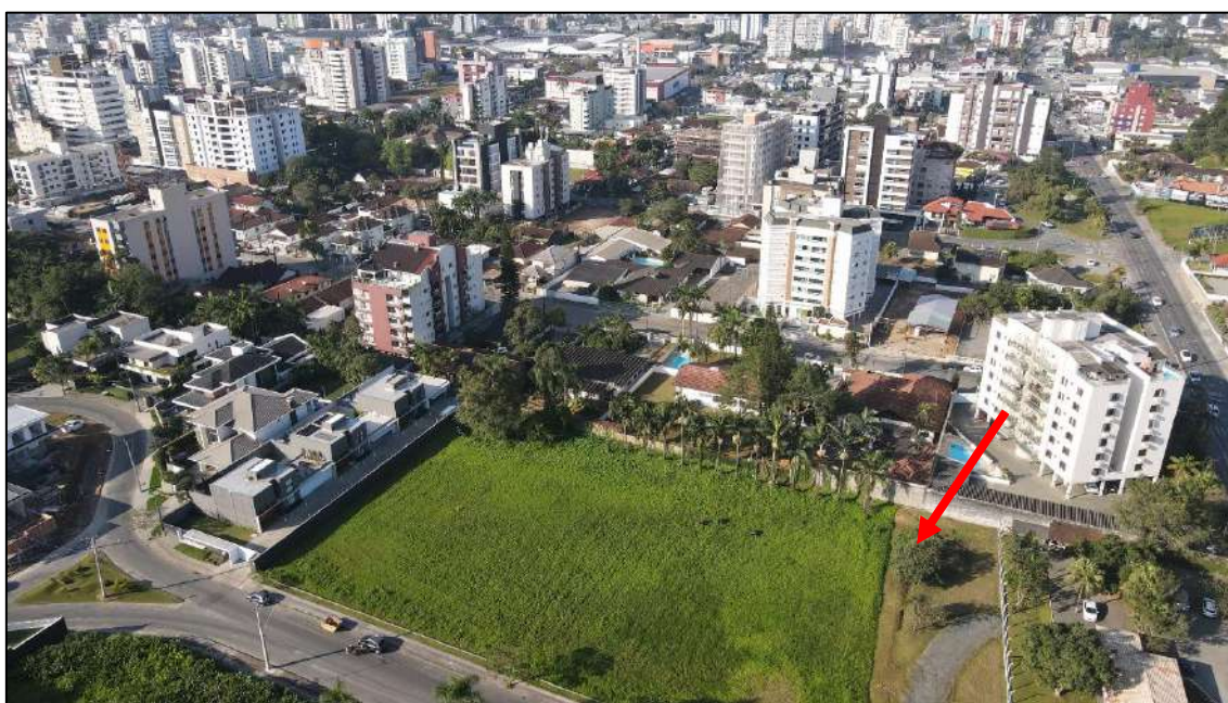
Foto 53: Imagem aérea demonstrando a localização do trecho 5 em relação ao entorno (04/07/2022).
