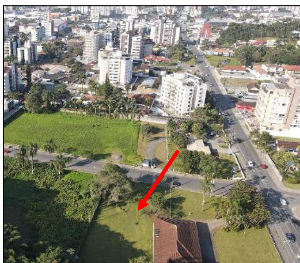
Foto 49: Traçado projetado para o trecho 4 tubulado (04/07/2022).
