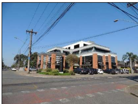
Foto 18: Elementos da distribuição de energia – posteamento, iluminação pública e fios de condução (Rua Benjamin Constant).
