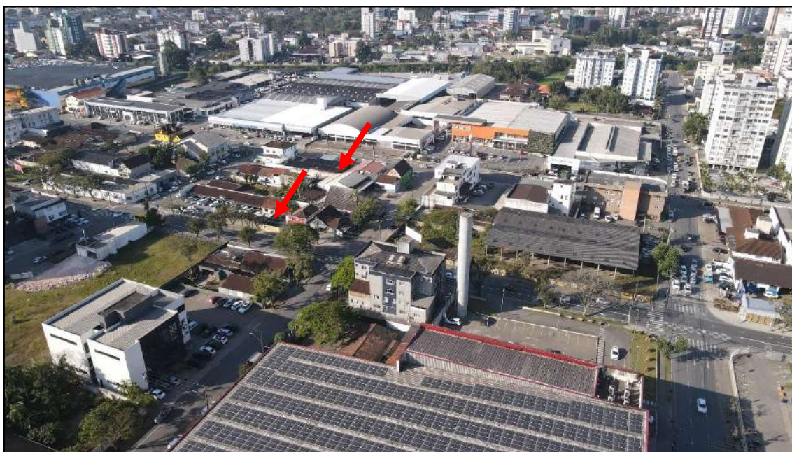
Foto 69: Imagem aérea demonstrando a localização dos trechos 12 e 14 (trecho canalizado em galeria aberta) em relação ao entorno (04/07/2022).
