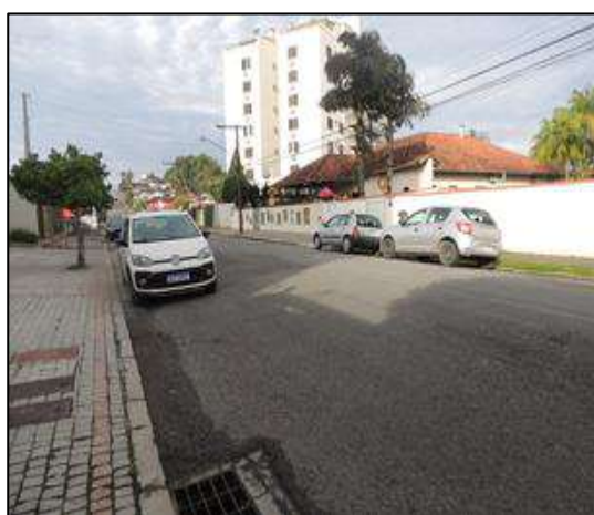
Foto 07: Quadrante D (trecho 07) - Detalhe da pavimentação asfáltica.
