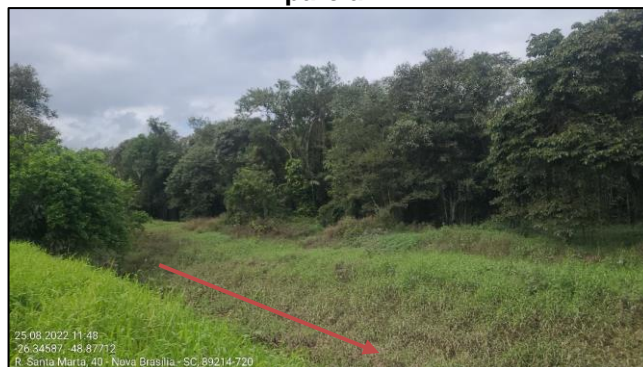
Figura 40 - Aspecto geral do trecho 34B, evidenciando a retificação do trecho e a vegetação densa parcial.
