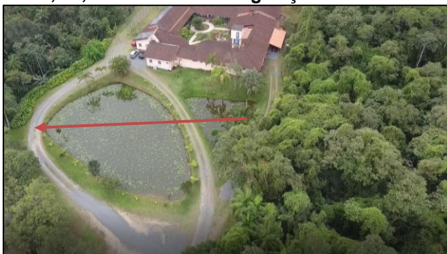
Figura 30 - Aspecto geral dos trechos 26, 27, 28, 29, evidenciando a vegetação isolada.
