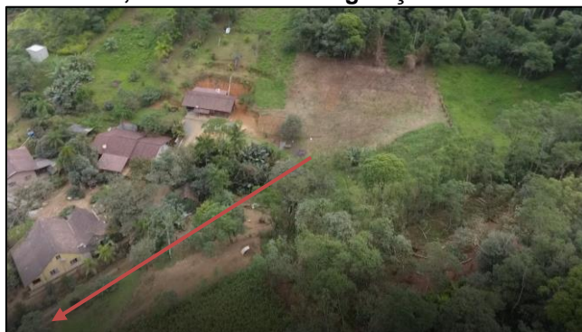
Figura 33 - Aspecto geral dos trechos 35A, 35B, 35C e 36, evidenciando a vegetação isolada.
