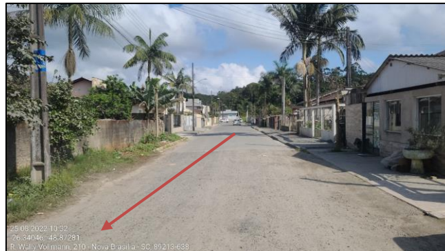
Figura 46 - Localização em campo do trecho 32, tubulado.
