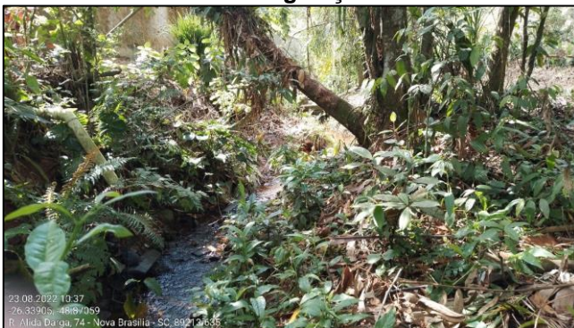
Figura 24 - Aspecto geral do trecho 2, evidenciando a vegetação isolada.
