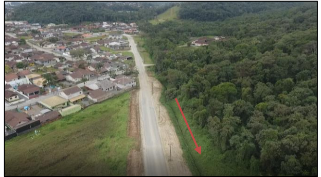
Figura 39 - Aspecto geral do trecho 33B, evidenciando a retificação do trecho e a vegetação densa parcial.
