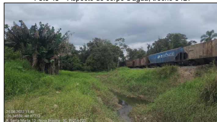
Foto 48 – Localização do início da tubulação, trecho 37.
