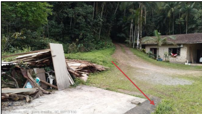
Figura 44 - Localização em campo dos trechos 10 e 11, tubulado.
