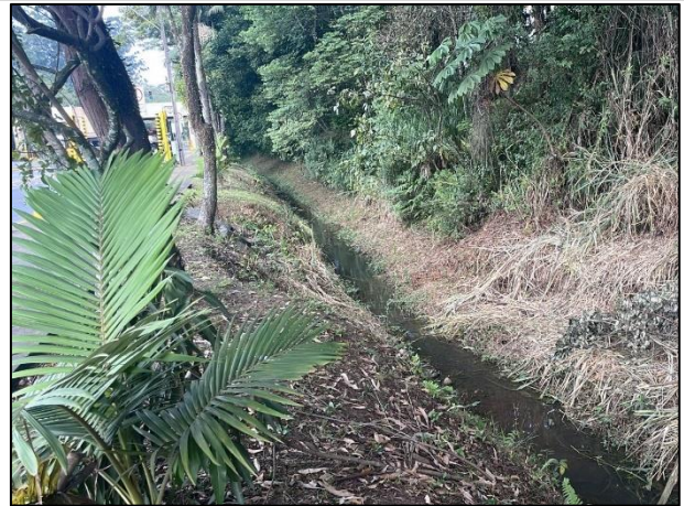
Figura 21: Vista para o trecho 36 com destaque para a vegetação isolada (Fonte: Carbono Engenharia, 2023).
