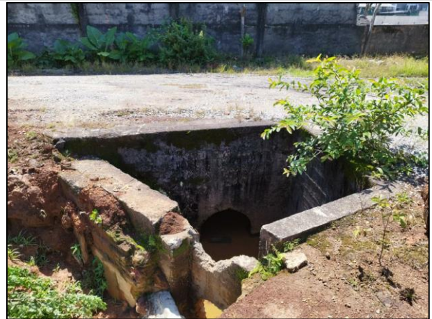
Figura 12: (R2) Vista trecho 21 com destaque ao início da tubulação (Fonte: Carbono Engenharia, 2023).
