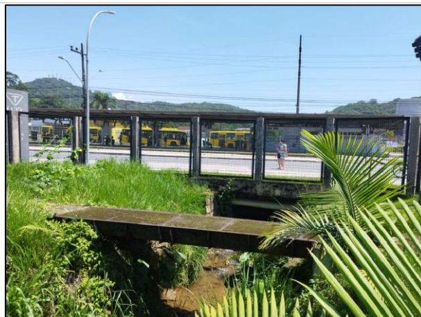
Figura 18: Vista para o início do trecho 35 com destaque para seu escoamento aberto (Fonte: Carbono Engenharia, 2023).
