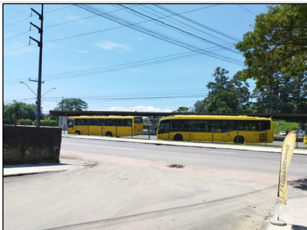
Figura 17: Vista para o trecho 34 com destaque a boca de lobo por onde ocorre o escoamento em sentido ao terminal Tupy (Fonte: Carbono Engenharia, 2023).
