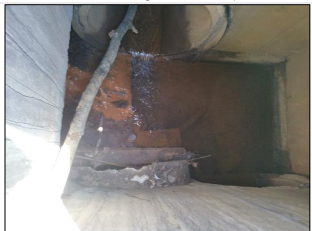
Figura 16: Vista da confluência dos trechos 21 e 33 com destaque para a tubulação (Fonte: Carbono Engenharia, 2023).
