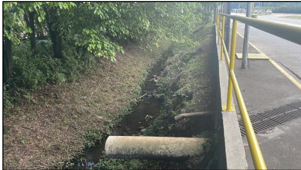
Figura 22: Vista para o trecho 37 com destaque a vegetação isolada e o solo impermeável (Fonte: Carbono Engenharia, 2023).
