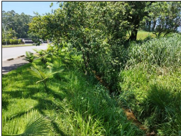
Figura 20: Vista para o trecho 35 com destaque para o seguimento do escoamento e a via lateral ao corpo hídrico (Fonte: Carbono Engenharia, 2023).
