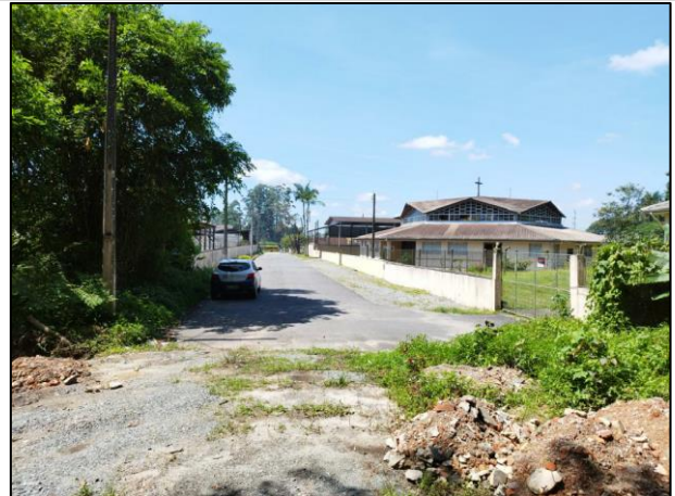
Figura 14: Vista para o trecho 33 com destaque para o trecho tubulado sob via pública (Fonte: Carbono Engenharia, 2023).
