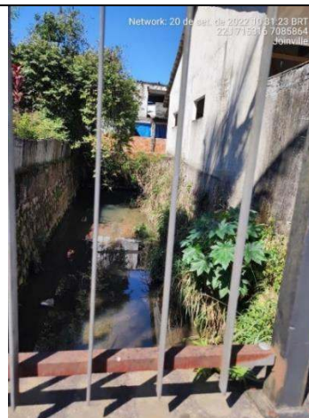
Figura 10: Trecho 8 canal/galeria aberta, vista da Rua Presidente Epitácio Pessoa para o sentido sul Fonte: Autor, 2022
