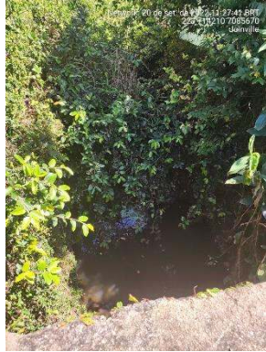
Figura 21: Trecho 23 canal/galeria aberta (Foto da Rua Colombia voltada para o sentido oeste) Fonte: Autor, 2022
