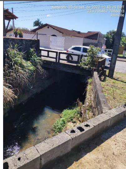
Figura 14: Trecho 9 canal/galeria aberta, vista para a Rua Paraguay Fonte: Autor, 2022
