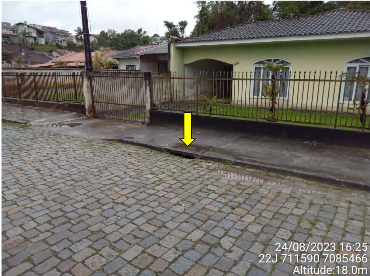
Figura 11: Rua Maria Goll, pavimentada por lajotas e paralelepípedos. Observa-se rede de distribuição de energia elétrica e boca de lobo para coleta de água pluvial. Fonte: Autores.
