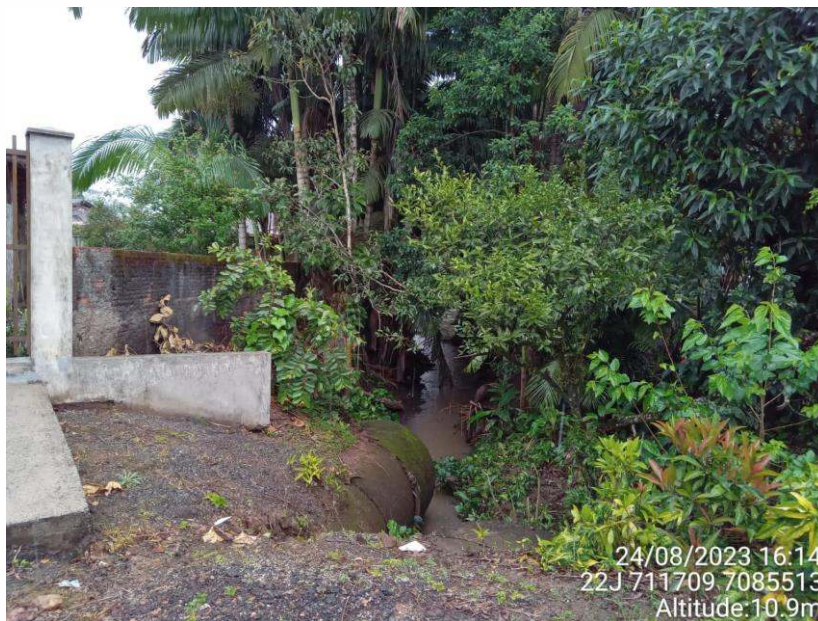
Figura 31: Saida do trecho 22 para o 23. Fonte: Autores.
