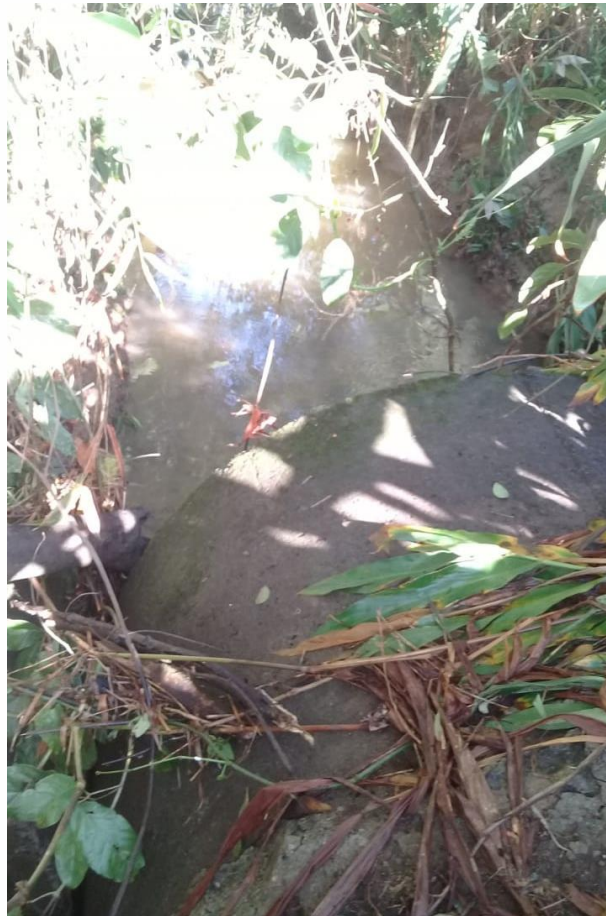
Figura 27: Trecho 23 para 24, tubulado.
