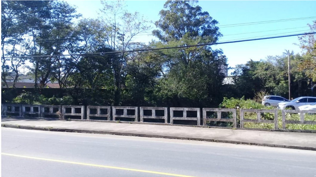
Figura 39: Vista para o trecho 70 e 71, a partir do trecho 69.
