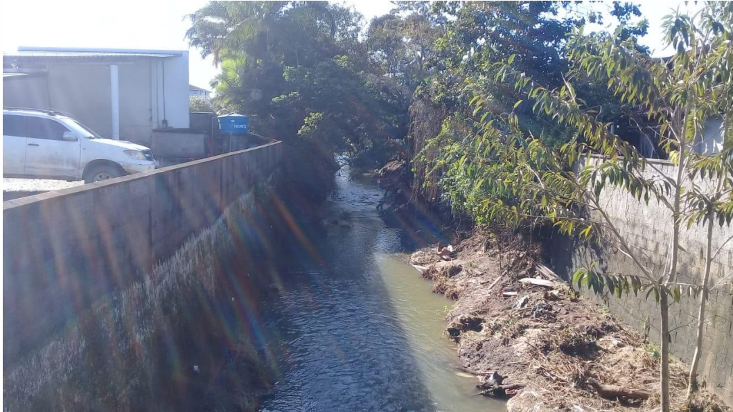
Figura 34: Trecho 57, vista a partir do trecho 56. Fonte: Autores.
