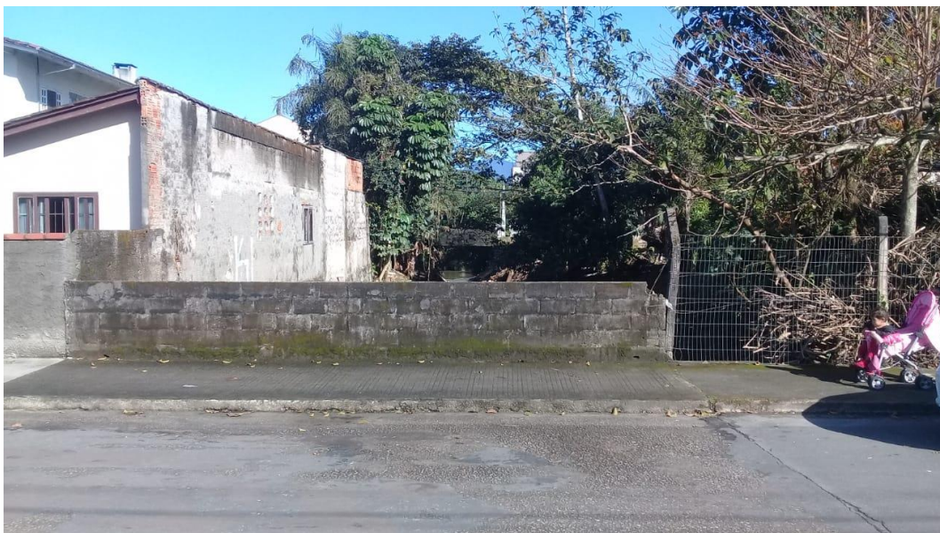
Figura 33: Trecho 55, vista a partir do trecho 56. Fonte. Autores.
