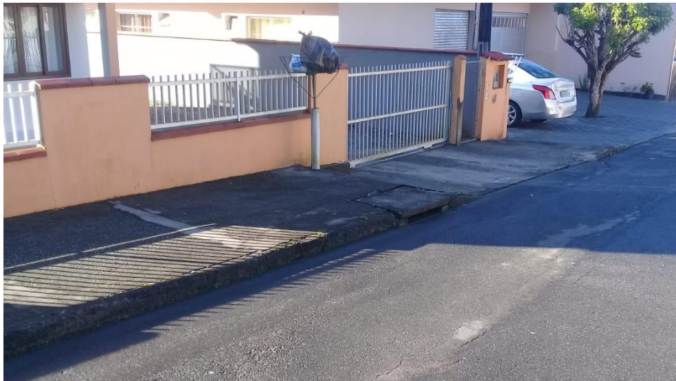
Figura 11: Boca de lobo na microbacia, rua Miguel José de Freitas.
