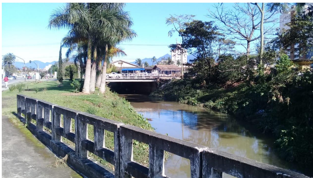
Figura 38: Trecho 65, com vista a partir do trecho 69. Trecho 67 aos fundos (ponte). Fonte: Autores.
